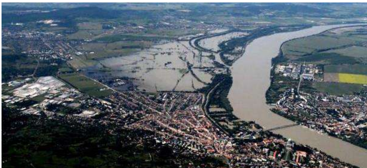
15. fig. Flood damages in 2013 (source: https://www.szeretgom.hu/content/78702-egesen-esztergom-kertvarosig-vezetnek-a-gatat )
