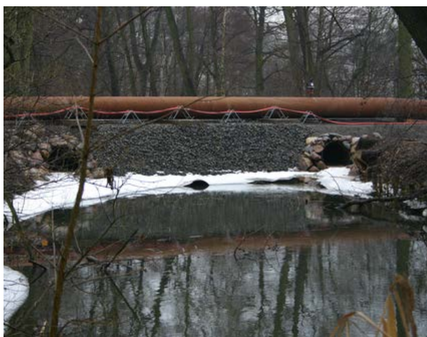
Fig.110. Canalele pentru vidre (tuneluri pentru vidre) sunt o soluție potrivită în locurile în care un pod este impracticabil pentru această specie. (Foto: Lukáš Poledník)
