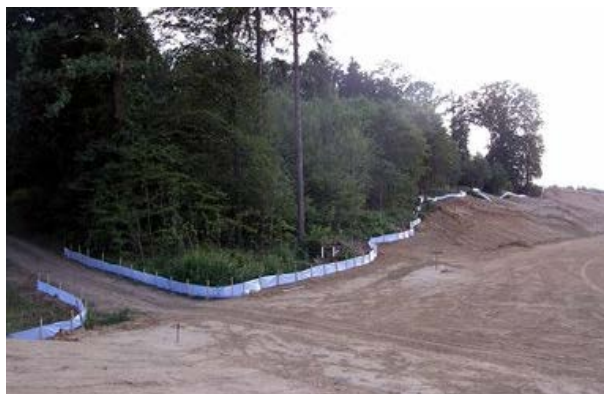
Fig.118. Barierele temporare sunt folosite pentru a împiedica pătrunderea amfibienilor pe șantier. În astfel de cazuri, animalele trebuie să fie îndreptate către un pasaj adecvat sau trebuie să fie capturate și transferate în mediul sigur. (Foto: Naturaservis, Ltd.)
