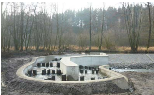
Fig.112. Pasaje pentru pești sub formă unui canal de deviație: pentru a depăși un obstacol de 1,3 m înălțime, a fost necesar să se creeze un pasaj pentru pești cu o lungime totală de 40 m. Republica Cehă. (Foto: Václav Hlaváč)
