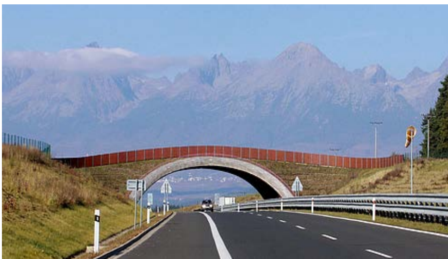
Fig.5. Pasajele pentru faună sunt o măsură care vizează reducerea impactului negativ al infrastructurii de transport asupra deplasării animalelor sălbatice (Foto: Václav Hlaváč)
