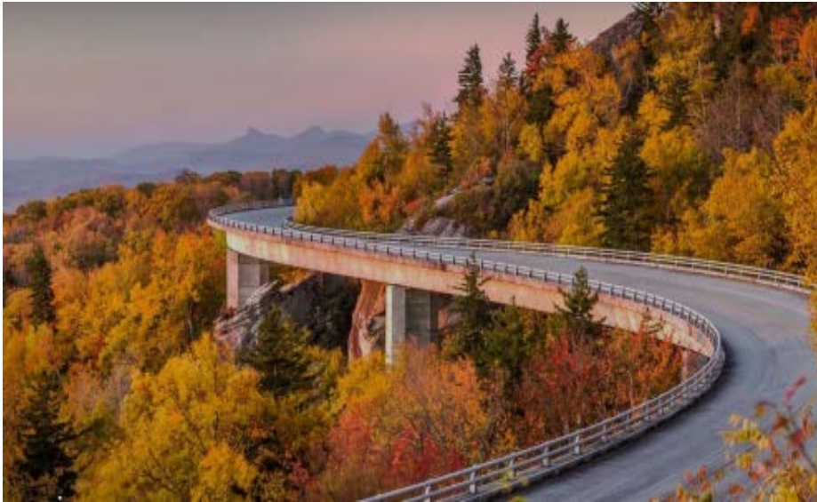
Fig. 52. În cazul în care infrastructura se ridică pe și urmează versantul unei văi, intruziunea poate fi semnificativă. În astfel de situații, lucrările de terasament trebuie să fie amplasate și proiectate corespunzător.
