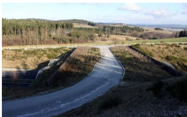
Fig. 93. Perturbațiile sunt eliminate de pereții de protecție (în acest caz, o balustradă adaptată). Un astfel de pasaj multifuncțional poate fi folosit de specii de mamifere mici, dar și de păsări mici, lilieci, specii arboricole etc. Germania. (Foto: Václav Hlaváč)
