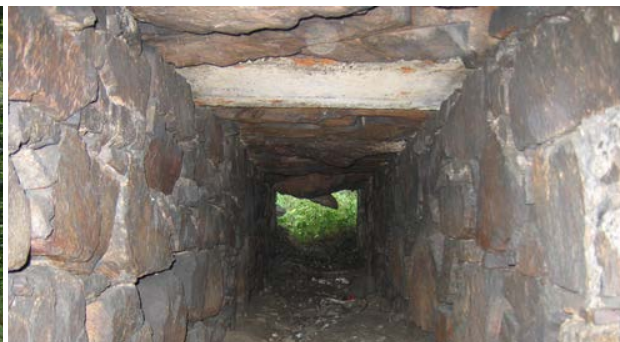
Fig.74. Mortalitatea Șarpelui lui Esculap poate fi prevenită prin instalarea unor bariere speciale de-a lungul infrastructurii de transport pe care șerpii nu o pot depăși. Barierele trebuie să ghideze animalele către canale suficient de mari, unde pot traversa în siguranță drumul. E442 / R13 lângă Strážnad Ohři, Republica Cehă. (Foto: Zamenis, z.s.)
