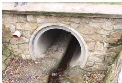
Fig. 107. Posibilitatea de utilizare a canalelor pentru animale poate fi mărită prin crearea unui mal care să permită mișcarea animalelor terestre. (Foto: Václav Hlaváč)
