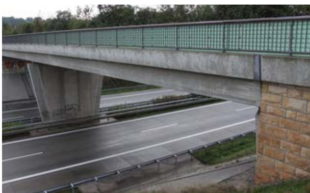
Fig.92. Un pasaj multifuncțional al cărui scop este și deplasarea animalelor. Atunci când este bine implementată, această soluție este potrivită pentru mamifere mici și mijlocii, dar mamiferele mari nu folosesc, de regulă, acest tip de soluție. Pasajele multifuncționale sunt complet de nedorit ca soluție pentru coridoarele ecologice de importanță regională. Písek, Republica Cehă. (Foto: Václav Hlaváč)
