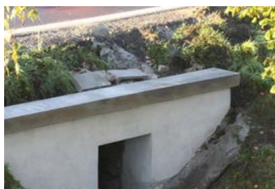
Fig.72. Canalul rectangular este întotdeauna o soluție mai bună pentru amfibieni decât un canal tubular. Substratul este foarte important pentru amfibieni, pavajul de piatră este o soluție optimă. (Foto: Václav Hlaváč)
