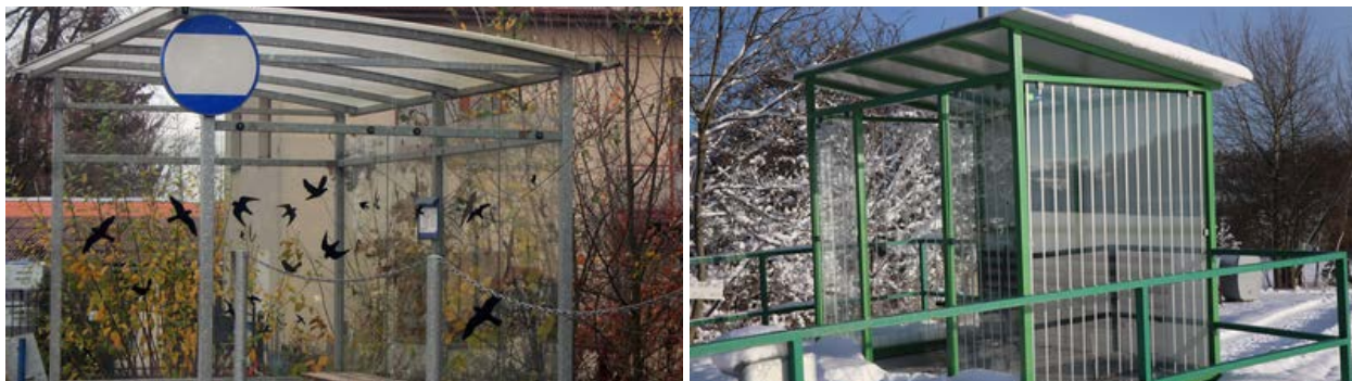
Fig.122. Stațiile de autobuz, la fel ca și pereții de protecție transparenti, cauzează o mortalitate crescută în rândul păsărilor. Mijloacele de securizare sunt similare în ambele cazuri. (Stația de autobuz din stânga a fost decorată de copii în cadrul unei activități școlare). (Foto: Petra Hulvová)
