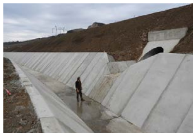
Fig. 66. Construcțiile masive de beton destinate drenajului apelor pluviale ce provin de pe autostradă, afectează în mod neplăcut peisajul și nu permit utilizarea canalelor ca pasaje pentru faună. O astfel de soluție reprezintă, de asemenea, o capcană pentru animalele mai mici care vor avea dificultăți în a părăsi canalul. (Foto: Ivo Dostál)
