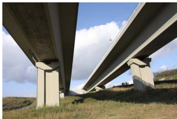
Fig. 98. Atunci când un viaduct are o structură divizată, suprafața de dedesubt are suficientă lumină și precipitații pentru dezvoltarea vegetației. Aceasta permite o mai bună conectare a habitatelor. Pe de altă parte, lățimea totală a zonei afectate este mai mare comparativ cu o construcție compactă. Ungaria. (Foto: Václav Hlaváč)
