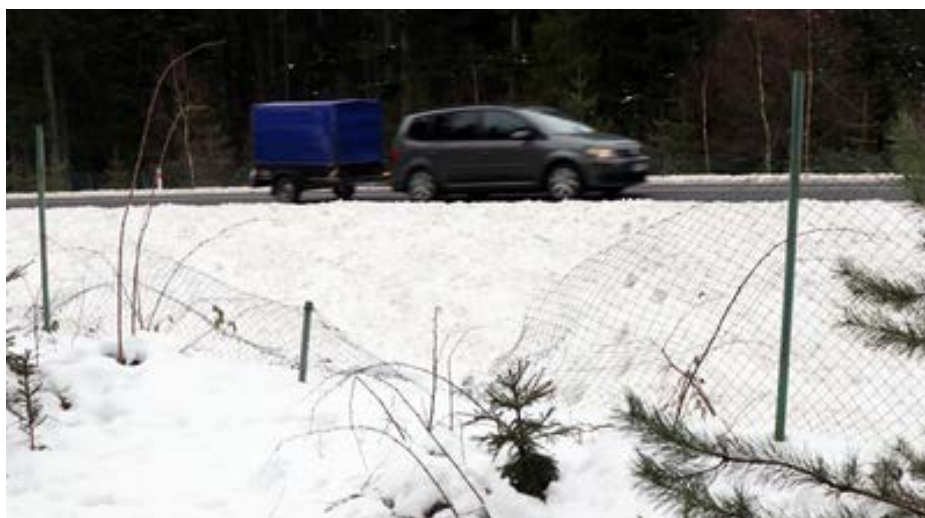
Fig.116. Gardurile pot fi adesea deteriorate de către arborii căzuți sau în urma accidentelor de circulație. (Foto: Václav Hlaváč)
