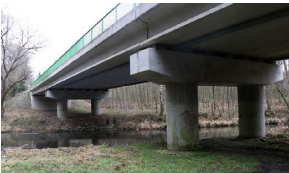
Fig. 41. Proiectarea corespunzătoare a unui pod peste un curs de apă permite atât mișcarea liberă a apei, cât și a animalelor semi-acvatice și terestre. Malurile suficient de mari, fără ajustări tehnice, permit mișcarea tuturor grupurilor de animale. Mai mult, podurile proiectate în acest mod pot face față în condiții de siguranță debitelor în timpul inundațiilor, asociate cu schimbările climatice. (Foto: Václav Hlaváč)
