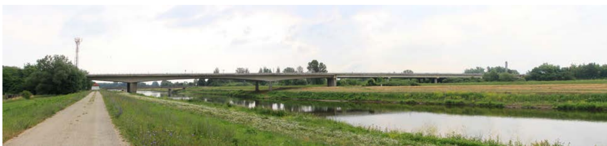
Fig. 40. În cazul în care este necesar să se traverseze peste zonele umede, un viaduct este de obicei soluția optimă. Cu toate acestea, pereții de protecție pentru a limita perturbațiile și pentru a preveni mortalitatea păsărilor sunt esențiale. (Foto: Ivo Dostal)
