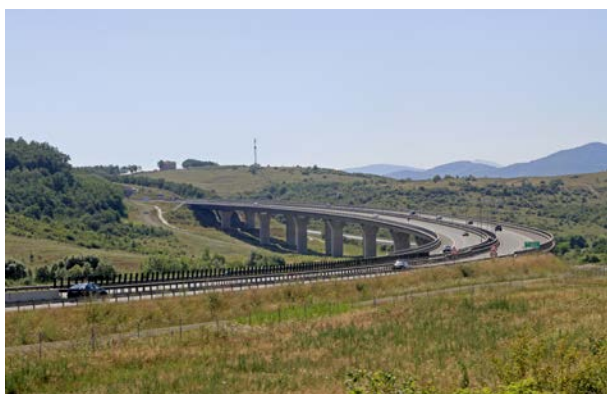
Fig. 55. Viaductele, în general, diminuează nivelul fragmentării și impactul negativ asupra habitatelor. Viaduct Săcel, România (Foto: Ivo Dostal)
