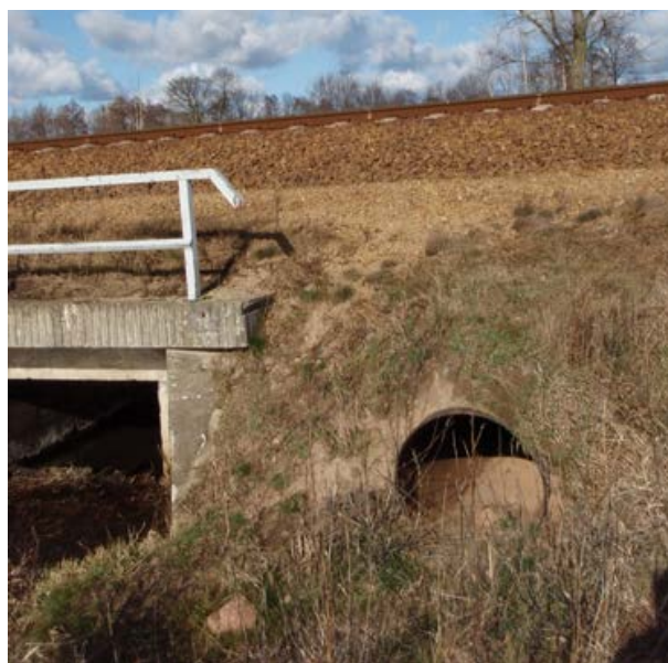
Fig.110. Canalele pentru vidre (tuneluri pentru vidre) sunt o soluție potrivită în locurile în care un pod este impracticabil pentru această specie. (Foto: Lukáš Poledník)
