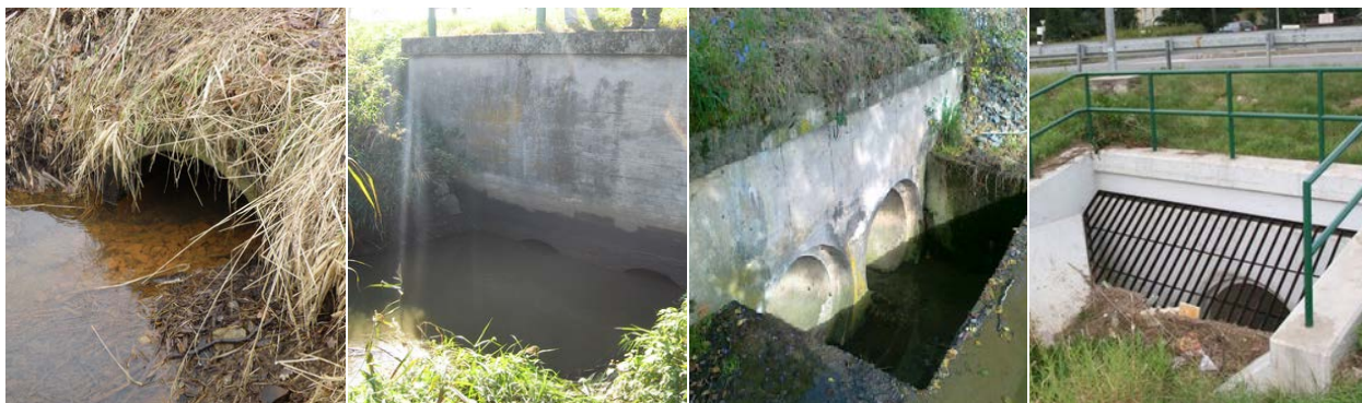
Fig.109. Exemple de soluții necorespunzătoare. Canale care nu permit pătrunderea animalelor (Foto: Lukáš Poledník - a) și d), Václav Hlaváč - b), Jitka Větrovcová - c))
