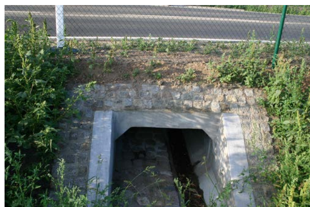
Fig. 54. Canale dreptunghiulare adecvate pentru trecerea mamiferelor până la mărimea vulpii sau viezurei sunt relativ ușor de construit în peisaje plate. (Foto: Lukáš Poledník)
