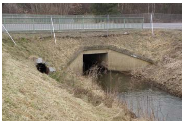
Fig. 78. În cazul în care nu este posibilă ajustarea punții necorespunzătoare ca pasaj pentru faună, se poate crea un tunel paralel pentru vidră. Se recomandă utilizarea barierelor de ghidare pentru a ajuta animalele să găsească intrarea. (Foto: Lukáš Poledník)
