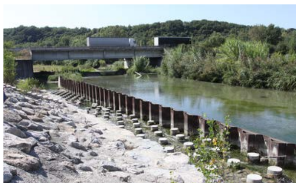
Fig.113. Pasaj pentru pești lângă Lyon, Franța. Pasajele pentru pești sunt plasate direct în cursul apei și sunt utilizate de întregul spectru de pești care se deplasează în respectivul curs de apă. De asemenea, sunt folosite și de vidre. (Foto: Václav Hlaváč)
