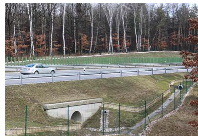
Fig. 108. În cazul în care intrarea într-un canal este pe un drum în afara zonei împrejmuite iar ieșirea pe partea cealaltă a drumului este în interiorul zonei împrejmuite, animalele care utilizează o astfel de subtraversare rămân prinse între garduri și drum. În cazul în care ambele intrări într-un canal se află în interiorul unei zone îngradite, podul nu poate fi utilizat de către animale. (Foto: Václav Hlaváč)
