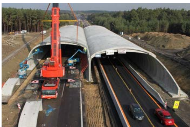
Fig. 86. Podul verde din apropierea Moravský Svätý Ján (Slovenia) a fost construit în timp ce autostrada D2 era deja dată în folosință. Inițial autostrada a avut o secțiune lungă complet impermeabilă; în acest loc autostrada intersectează coridorul ecologic alpin-carpatic. (Foto: NDS)
