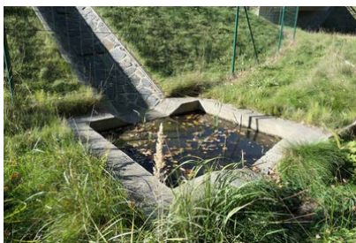
Fig. 64. Un mic rezervor de retenție devine o capcană pentru multe animale mici atunci când nivelul apei scade. Astfel, se recomandă proiectarea unor rezervoare naturale sau care să aibă cel puțin un perete înclinat, pentru a facilita ieșirea animalelor. D1, Republica Cehă. (Foto: Petr Anděl)
