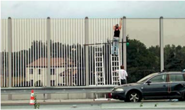
Fig. 123. Un perete de protecție împotriva zgomotului pe autostrada D47 din Republica Cehă. În 2008, în aproximativ 6 luni, au fost găsite aproape 200 de păsări moarte de-a lungul unui sector de doar 1 km, între Bohumín și Ostrava. Mortalitate a scăzut după ce pe peretele de protecție au fost adăugate dungi verticale. (Foto: Jan Mayer)
