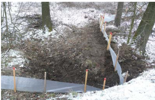
Fig.117. În timpul migrațiilor de primăvară, instalarea barierele temporare poate împiedica pătrunderea amfibienilor pe căile de transport și, în același timp, îi poate direcționa către pasaje sigure. Barierele vor fi eliminate după ce are loc migrația acestor specii. (Foto: Jaromír Maštera)
