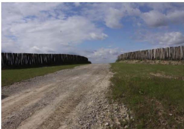
Fig. 95. Un pasaj multifuncțional ca acesta are o utilizare limitată pentru faună. Locurile de ascundere și microhabitatele adecvate pentru animalele mici lipsesc, la fel ca și tufișurile pentru animalele mai mari. (Foto: Václav Hlaváč)
