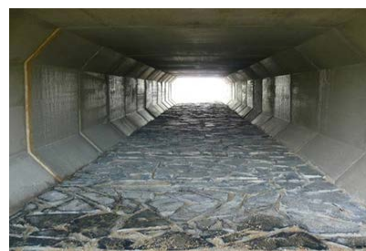
Fig.72. Canalul rectangular este întotdeauna o soluție mai bună pentru amfibieni decât un canal tubular. Substratul este foarte important pentru amfibieni, pavajul de piatră este o soluție optimă. (Foto: Václav Hlaváč)
