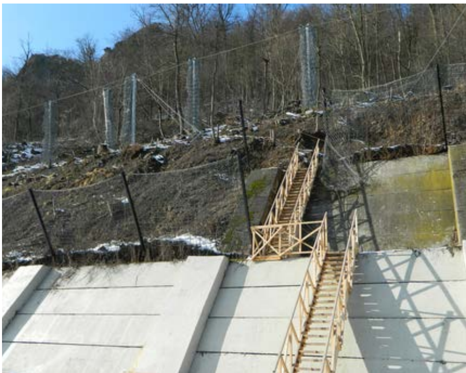
Fig.60. Pante abrupte consolidate de un gard de prindere sau o plasă de sârmă împotriva căderii pietrelor. Aceste măsuri sunt uneori necesare pentru stabilizarea versanților, dar în același timp reprezintă o întărire a efectului de barieră și distrugerea zonelor verzi. Dacă este posibil, ar trebui preferată o soluție cu impact mai redus. R2, Zvolen, Slovacia. (Foto: Miroslav Jarný)
