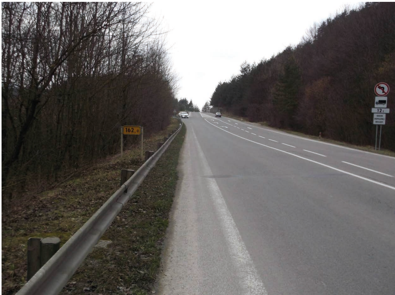
Obr. 54: Pohľad na biokoridor a cestu I/61 s hustou vegetáciou po oboch stranách.
