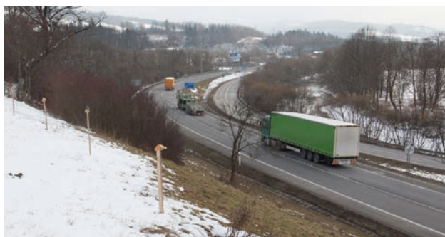
Obr. 21: Pohľad na časť biokoridoru a cestu I/11 a II/11A. Rieka tečie pozdĺž cesty.
