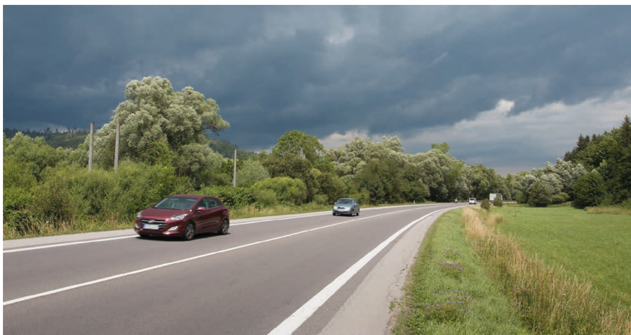
Obr. 30: Pohľad na biokoridor Povina a cestu I/11
