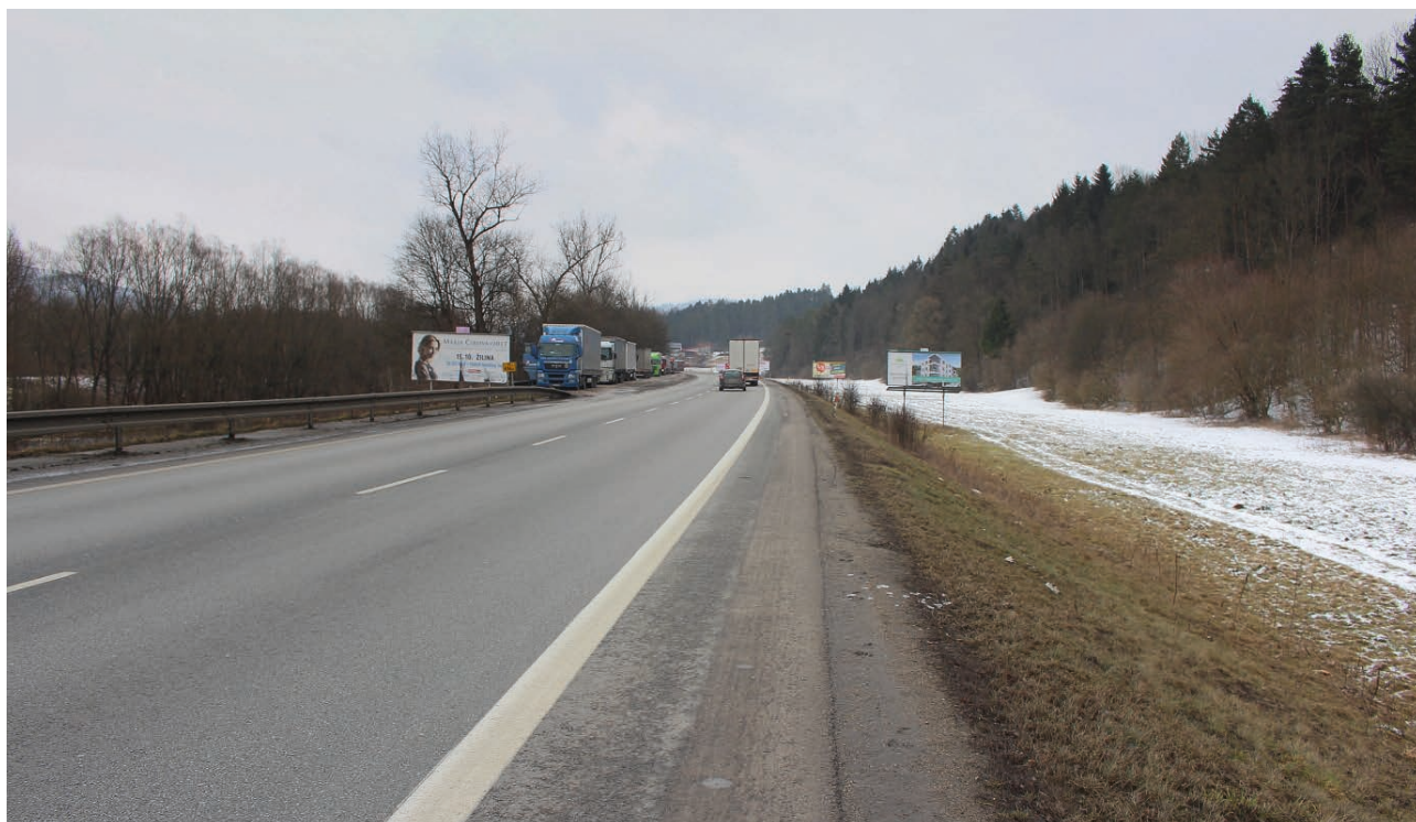
Obr. 33: Biokoridor Oškerda v kolízii s cestou I/11.
