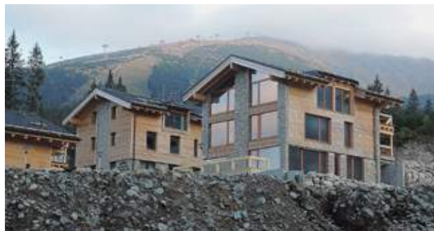
Obr. 6.4 Výstavba rekreačních středisek v horském prostředí s sebou vždy přináší rozvoj dopravní infrastruktury. Jasná, Nízké Tatry. © Barbara Immerová
