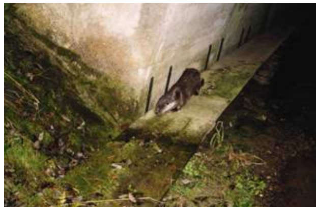
Obr. 10.13 V případě nevhodně řešených mostů, kde suché břehy neexistují, je možné dodatečně vybudovat „zvířecí lávky“. I zde musí být zachována přirozená návaznost „chodníku“ na břehy toku. © Václav Hlaváč
