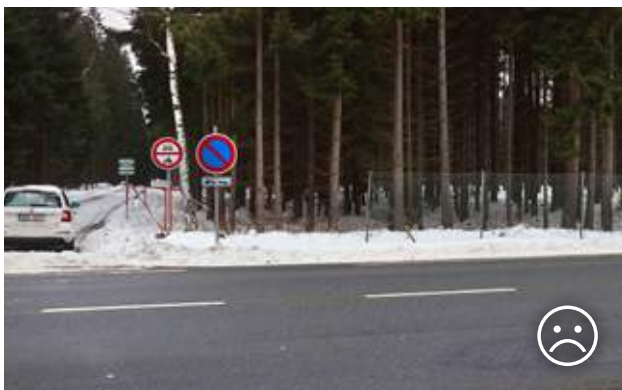
Obr. 10.52 Oplocení přerušené odbočující lesní cestou. Tato silnice první třídy byla oplocena kvůli vysokému počtu srážek se zvěří. Jelikož je na ni takovýmto způsobem napojeno několik lesních cest, ztratilo přerušené oplocení svoji funkčnost. Počet zaznamenaných nehod v daném úseku po instalaci oplocení dokonce vzrostl. Zvěř překonávající komunikaci se totiž dostala dovnitř oploceného úseku bez možnosti úniku. © Václav Hlaváč
