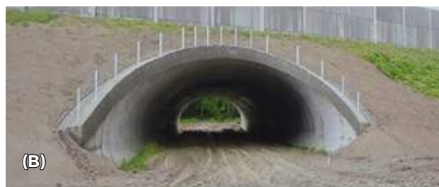
Obr. 10.37 Chování živočichů v blízkosti podchodu jasně poukazuje na fakt, že vnímají hluk způsobený projíždějícími vozidly (uložení mostní konstrukce) (A). Při výstavbě nových mostů je proto vždy nutné vybírat taková technická řešení, která minimalizují rušení hlukem v podmostí. Toho lze nejlépe docílit použitím vrstvy zeminy mezi mostní konstrukcí a samotnou komunikací (B). Ve srovnatelných podmínkách ale toto řešení bohužel vždy přináší redukcii rozměrů podmostí. © (A) Hnutí DUHA Olomouc, (B) AOPK ČR
