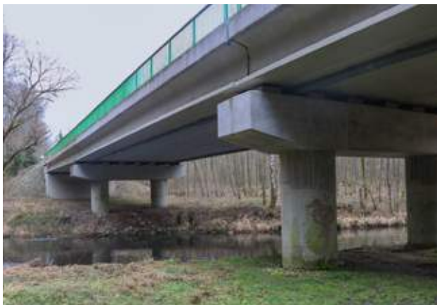
Obr. 6.41 Správně navržený most přes vodní tok umožňuje volný pohyb vodních, semiakvatických i suchozemských živočichů. Dostatečně široké břehy bez technických úprav zajišťují průchodnost pro všechny kategorie živočichů. Kromě toho jsou takto navržené mosty schopny bezpečně převádět povodňové průtoky vody související se změnou klimatu. © Václav Hlaváč
