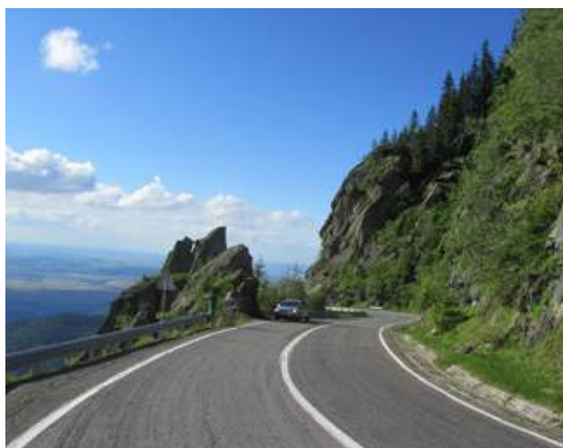
Obr. 9.2 Silnice vedoucí po strmém horském svahu je často z jedné strany v zářezu a z druhé ve strmém náspu – toto řešení představuje pro živočichy těžko překonatelnou překážku. © Ján Kadlecík
