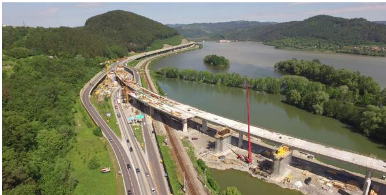
Obr. 8.10 Výstavba dálnice paralelně se silnicí nižší třídy, železnici nebo říčním kanálem vytváří vícenásobný bariérový účinek. © archiv NDS
