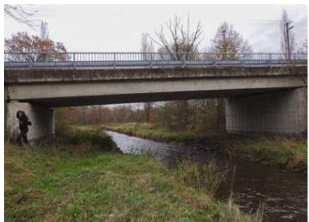
Obr. 9.9 Správně navržený most přes potok, který umožňuje pohyb většiny skupin živočichů. © Lukáš Poledník
