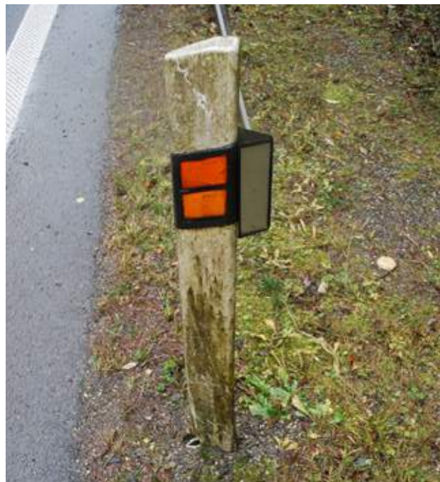
Obr. 12.19 Průmyslově vyráběný odpuzovač zvěře montovaný na silniční patník. Reflexní prvek odráží světlo od blížícího se auta ke straně silnice a tím varuje zvířata. Pokles úmrtnosti živočichů v důsledku instalace těchto světelných odrazujících prostředků nebyl dosud uspokojivě potvrzen. Beskydy, Česká republika. © Martin Strnad
