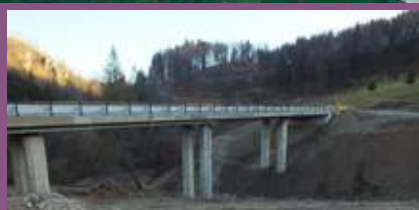
B) Výstavba nového mostu na pilířích – koridor je částečně funkční. Je ještě nutné vysadit naváděcí vegetaci pod mostem a v jeho okolí. © Drahoš Blanár
