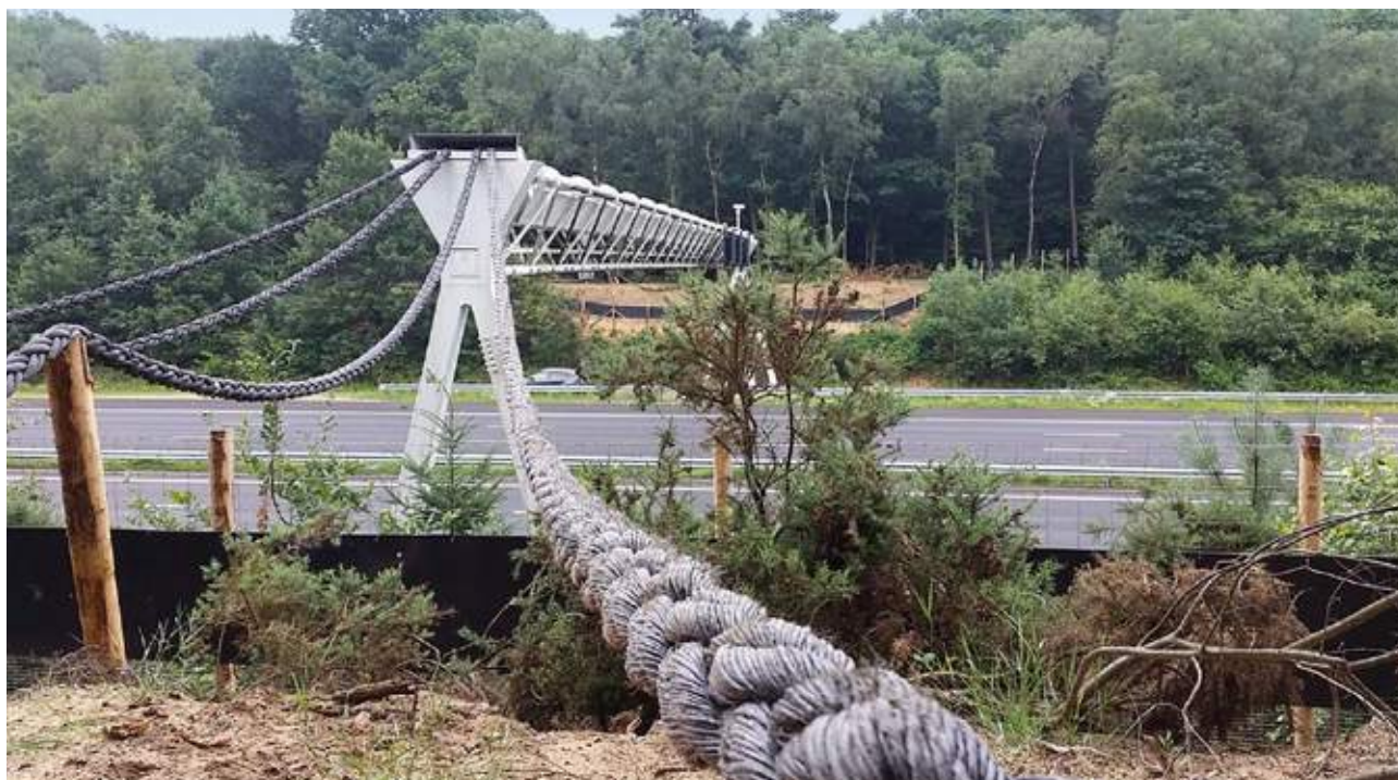
Obr. 10.16 Příklad speciálního nadchodu pro savce žijící na stromech: můstek přes dálnici A12 (Utrecht–Arnhem, blízko Wofheze, Nizozemí), upraven pro využití kunou lesní. Můstek vytváří pochozí cestu a pomocí silných lan propojuje okraje nedalekého lesa na obou stranách komunikace. Využívání tohoto nadchodu zmíněným druhem již bylo zdokumentováno pomocí fotopasti. © Jan Willem Burgmans, Heijmans Infra
