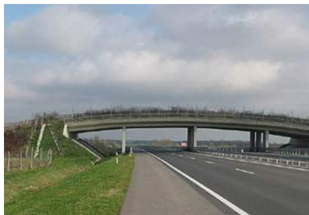
Obr. 6.42 Zelený most lze vybudovat i v rovinaté krajině, kde dálnice vede ve stejné úrovni s terénem. Spojení mostu s okolním terénem však zabírá větší plochu než v případě dálnice vedoucí v zářezu. Dálnice M7, Maďarsko. © Ábrahám László
