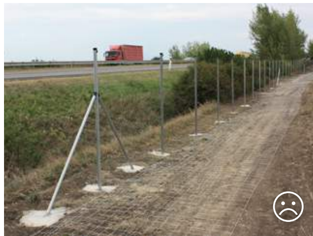
Obr. 9.24 Vzrostlá vegetace mezi dálnicí a oplocením živočichy přitahuje, protože se často jedná o jedinou vegetaci v intenzivně využívané zemědělské krajině. Je-li plot poškozen, zvířata se mohou snadno dostat mezi plot a dálnici, kde jsou uvězněna. Plot navíc není přes stromy z dálnice vidět, poškození proto není často včas odhaleno a vzrůstá tak riziko střetů zvířat s vozidly. © archiv NDS
