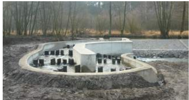
Obr. 10.49 Rybí přechod řešený formou obtoku. Pro překonání 1,3 m vysokého jezu bylo nutné vybudovat rybí přechod o celkové délce 40 m. Česká republika. © Bohumila Jermlová
