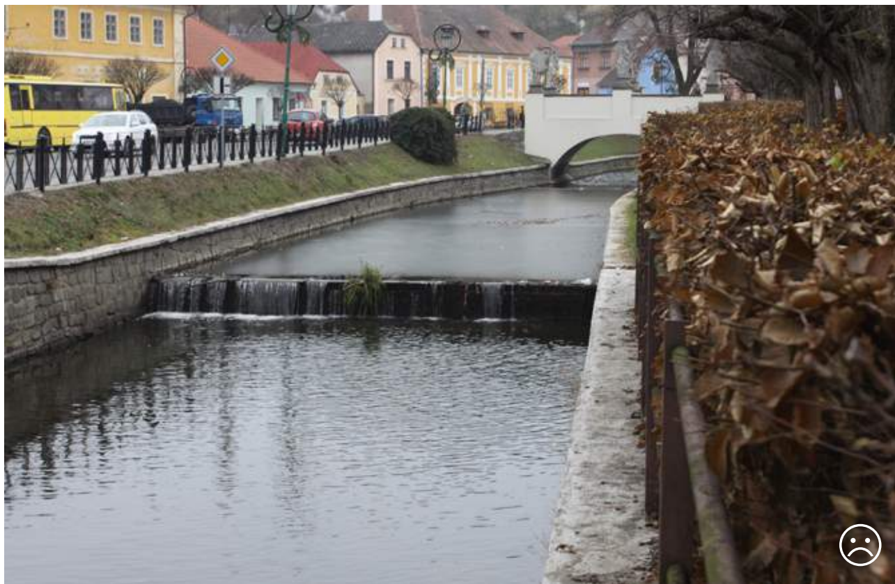
Obr. 10.15 Jez v kombinaci se svislým opevněním na obou březích vodního toku ve městě přinutí zvířata jako jsou vydra nebo bobr tyto překážky obcházet překonáváním silnice. © Václav Hlaváč
