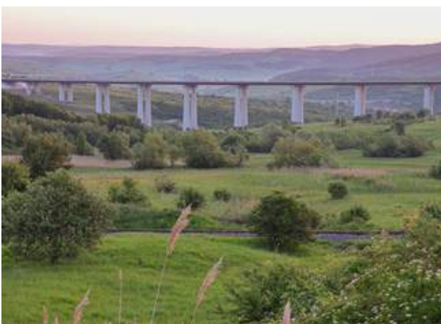
Obr. 9.8 Viadukty jsou k překonání údolí zpravidla vhodnější než násypy, protože umožňují volný pohyb živočichů a částečné zachování konektivity krajiny. Viadukt Aciliu na dálnici A1 (Bukurešť–Nadlac) v Rumunsku, župa Sibiu. © Tibor Sos
