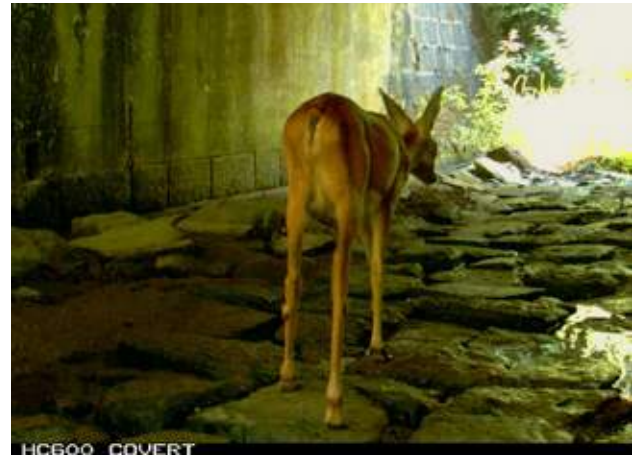
Obr. 10.20 Srnec obecný obvykle využívá podchody s indexem otevřenosti vyšším než 1. Tento podchod pod železnicí je 5 m široký, 3 m vysoký a 15 m dlouhý (IO=1). © Václav Hlaváč, fotopast
