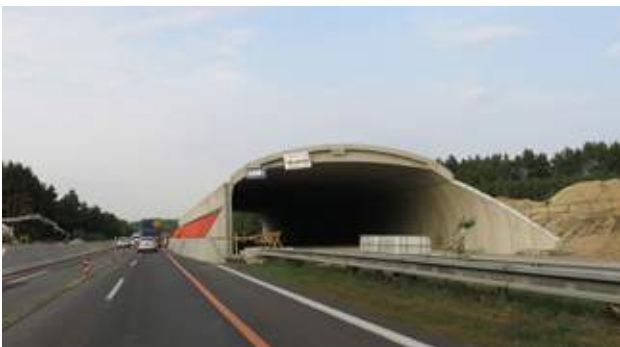
Obr. 8.11 Zelený most poblíž Moravského Svätého Jánu (Slovensko) byl vybudován za provozu stávající dálnice D2. V původní podobě byl dlouhý úsek dálnice zcela neprůchodný. Dálnice v tomto místě kříží Alpsko-karpatský migrační koridor. © Václav Hlaváč
