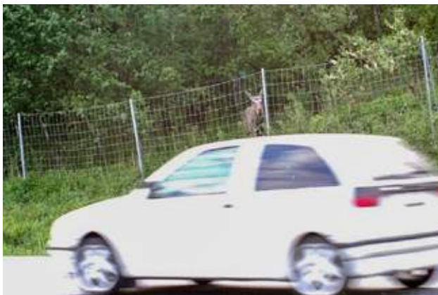
Obr. 12.18 Sledování účinnosti oplocení je z pohledu metodiky obtížnou otázkou. Při jeho posuzování je třeba mít na paměti, že ploty mohou mortalitu pouze přesunout na navazující neoplocené úseky. Instalace plotů musí být vždy spojena s dostatečným množstvím průchodů pro živočichy, které bariérový efekt plotů eliminují. © Václav Hlaváč
