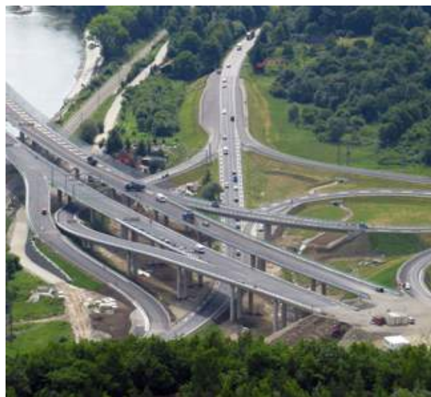
Obr. 9.15 Dopravní křižovatky vždy znamenají nezanedbatelný zábor území. Při jejich projektování je třeba zabránit ničení cenných společenstev a vytváření ekologických pastí pro živočichy, pro něž jsou stanoviště uvnitř křižovatek atraktivní, nebo pro zvířata migrující podél dálničních plotů. Křižovatka poblíž obce Vrútky, Slovensko. © Tomáš Flajs
