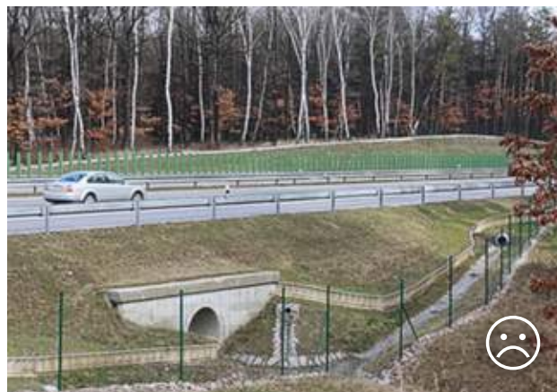
Obr. 10.45 Pokud je vstup do propustku na jedné straně mimo oplocení a na druhé straně uvnitř oplocení, živočichové zůstanou při průchodu uvěznění mezi oplocením a komunikací. V případě, kdy jsou oba vstupy do propustku oploceny, je takový propustek pro živočichy zcela nevyužitelný. © Václav Hlaváč
