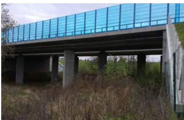
Obr. 10.38 Přirozený povrch zásadně zlepšuje využitelnost podchodu pro volně žijící živočichy. Protihluková stěna na mostě zmírňuje rušení dopravou a tím zvyšuje jeho funkčnost. Průhledné stěny musí být upraveny tak, aby se zabránilo zranění ptáků. Česká republika. © AOPK ČR
