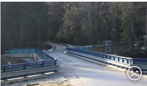
Obr. 10.31 Na tomto mostě spojujícím lesní cestu bylo pro eliminaci rušivých vlivů nainstalováno zábradlí s neprůhlednou výplní. Jelikož je ale asfaltový povrch pro pohyb živočichů nevhodný a není zde prostor pro rozvoj vegetace, lze považovat takové řešení obecně za nedostačující. Česká republika, dálnice D1 u Jihlavy. © Václav Hlaváč
