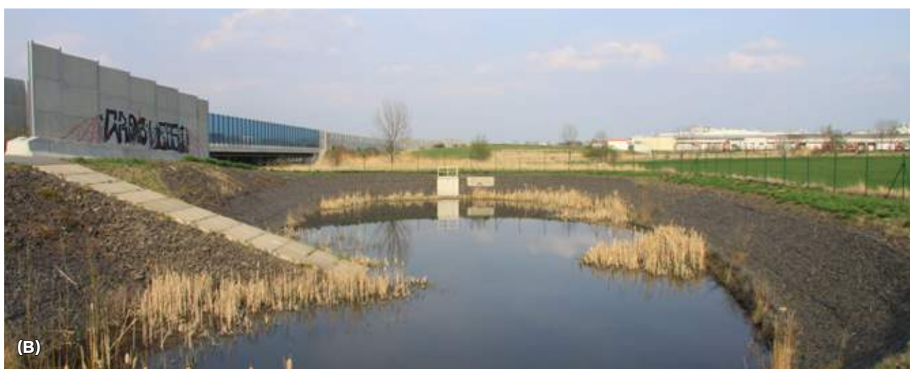
Obr. 4.12 Nádrže na zachycování vody z dálnic jsou někdy součástí jejich výstavby. Pokud jsou konstruovány jako betonové jímký s kolmými stěnami (A), vytvářejí pasti pro mnoho živočichů. Optimálním řešením je navrhovat tyto nádrže jako přírodní biotopy (B). © Petr Anděl (A) a Martin Strnad (B)
