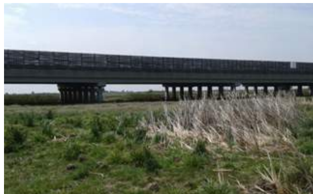
Obr. 6.40 Viadukt je obvykle optimálním řešením pro překonání mokřadů. Nezbytná však je instalace ochranných stěn, které omezí rušivé vlivy a úmrtnost ptáků v důsledku střetů s vozidly. Dálnice M3, Maďarsko. © András Szirányi
