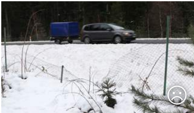
Obr. 10.56 Oplocení je často poškozené např. popadanými stromy nebo po nehodách. Zvěř obvykle takovéto otvory najde velmi rychle a dostává se tak do nebezpečné oblasti uvnitř oplocení. V případě vyrušení pak vyběhne přímo na komunikaci a stává se obětí dopravy. © Václav Hlaváč
