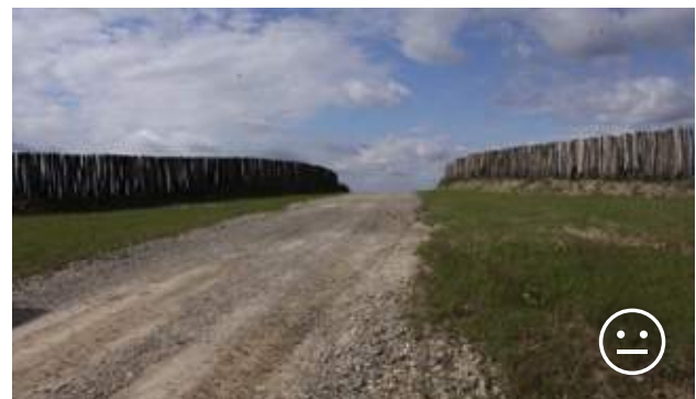
Obr. 10.32 Takovýto víceúčelový nadchod má pro volně žijící živočichy pouze omezené využití. Chybí zde úkryty a mikrobiotopy pro malé druhy a keře pro větší druhy. Potřeba úkrytů je o to vyšší, že zvěř nevidí bezpečnou krajinu na druhé straně nadchodu. © Václav Hlaváč
