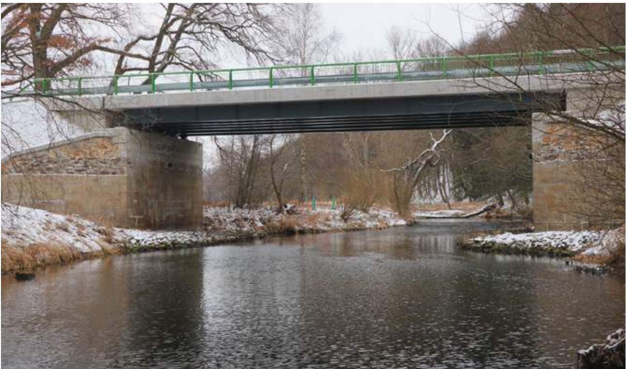
Obr. 10.1 Mosty přes vodoteče mohou být snadno upraveny tak, aby živočichům umožnily bezpečný průchod pod komunikací. Je nezbytné zachovat přirozené břehy pro návaznost terénu. © Václav Hlaváč
