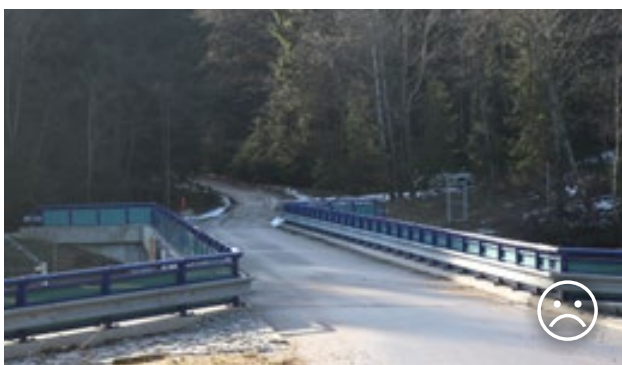
Obr. 10.31 Na tomto mostě spojujícím lesní cestu bylo pro eliminaci rušivých vlivů nainstalováno zábradlí s neprůhlednou výplní. Jelikož je ale asfaltový povrch pro pohyb živočichů nevhodný a není zde prostor pro rozvoj vegetace, lze považovat takové řešení obecně za nedostačující. Česká republika, dálnice D1 u Jihlavy.
