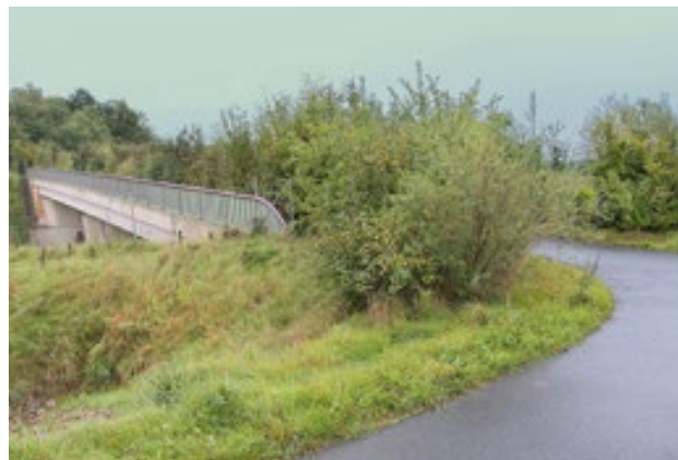
Obr. 10.17 Lesní cesta přes dálnici rozšířená o pruhy s keří po obou stranách umožňuje propojení lesního prostředí pro mnoho druhů živočichů, včetně savců žijících na stromech, drobného ptactva nebo netopýrů. Představuje velmi dostupné opatření s výrazným efektem. Drážďany, Německo. © Václav Hlaváč
