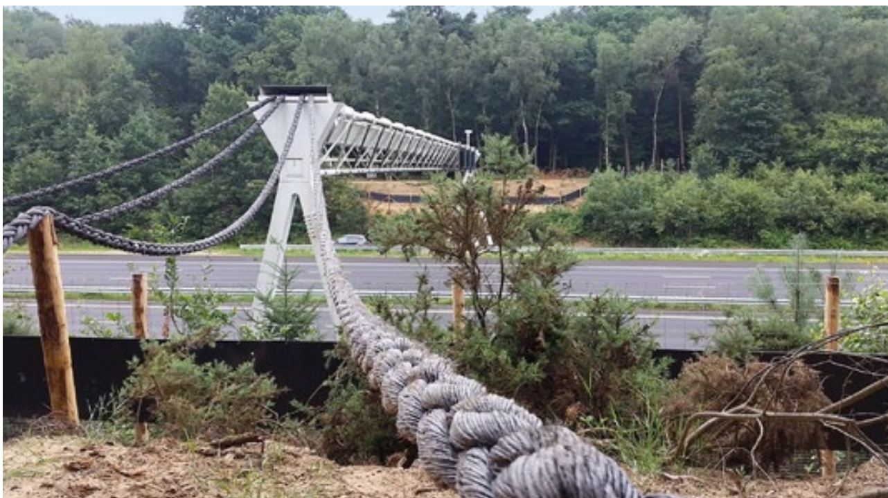
Obr. 10.16 Příklad speciálního nadchodu pro savce žijící na stromech: můstek přes dálnici A12 (Utrecht–Arnhem, blízko Wofheze, Nizozemí), upraven pro využití kunou lesní. Můstek vytváří pochozí cestu a pomocí silných lan propojuje okraje nedalekého lesa na obou stranách komunikace. Využívání tohoto nadchodu zmíněným druhem již bylo zdokumentováno pomocí fotopasti. © Jan Willem Burgmans, Heijmans Infra
