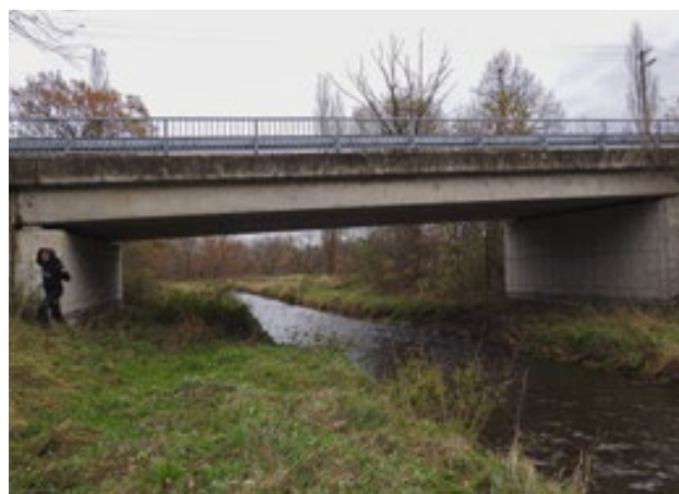
Obr. 9.9 Správně navržený most přes potok, který umožňuje pohyb většiny skupin živočichů. © Lukáš Poledník
