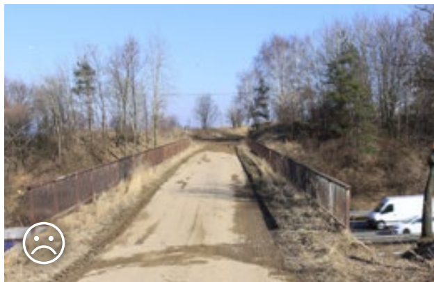
Obr. 10.10 Mosty převádějící polní a lesní cesty, které jsou pokryté betonem či asfaltem, nejsou zvěří využívány. Nadchody se zelenými pásy po obou stranách někdy využívá zajíc, kuna skalní nebo liška. Rušivý vliv dopravy způsobený hlukem je v případě dálnic pro většinu živočichů limitujícím faktorem. © Václav Hlaváč
