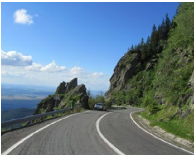
Obr. 9.2 Silnice vedoucí po strmém horském svahu je často z jedné strany v zářezu a z druhé ve strmém náspu – toto řešení představuje pro živočichy těžko překonatelnou překážku. © Ján Kadlecík
