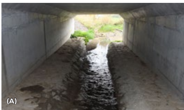
Obr. 10.42 Jako průchody pro malé volně žijící živočichy jsou snadno použitelné různé typy mostů přes vodoteče. Suché břehy po obou stranách v minimální šířce 0,5 m umožňují pohyb širokému spektru druhů až do velikosti jezevce. Ty by měly být zhotoveny z kamenné dlažby. Použití betonových chodníků je nevhodné, jelikož neumožňuje migraci obojživelníků (riziko vysychání). © Václav Hlaváč
