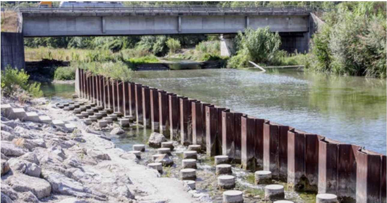
Obr. 10.50 Rybí přechod poblíž Lyonu ve Francii, kde na vodním toku vznikl v důsledku vybudování silniční komunikace výškový stupeň. Rybí přechod je vybudován přímo na vodním toku a je využíván všemi druhy ryb, které se zde vyskytují. Pro průchod ho též využívá vydra. © Václav Hlaváč
