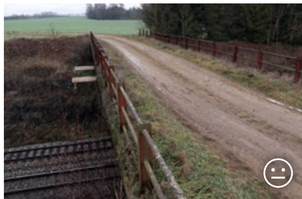
Obr. 10.2 Víceúčelový nadchod přes dvojkolejnou trať Praha-Brno (Česká republika) o šířce 7 m a délce 35 m. Travnaté pruhy po stranách nadchodu jsou využívány širokým spektrem bezobratlých živočichů. Díky hliněnému povrchu funguje nadchod jako průchod pro srnce, zajíce, lišku a mnoho dalších druhů menších obratlovců, včetně ještěrky obecné. Podobné mosty přes dálnice jsou využívány jen výjimečně, jelikož rušivé vlivy způsobené dopravou jsou zde mnohonásobně vyšší než u železnice. © Václav Hlaváč
