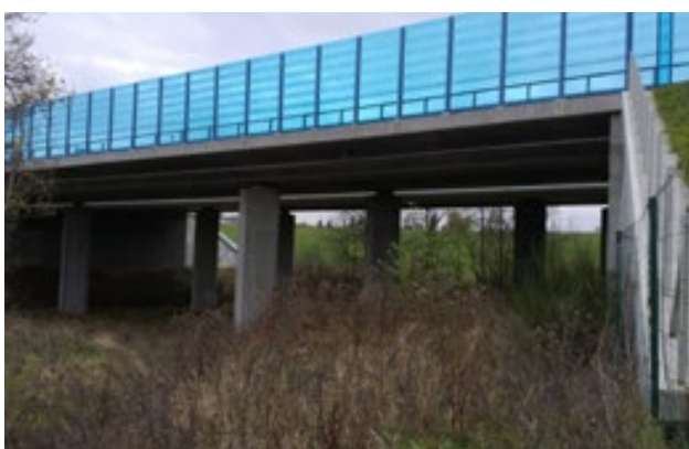
Obr. 10.38 Přirozený povrch zásadně zlepšuje využitelnost podchodu pro volně žijící živočichy. Protihluková stěna na mostě zmírňuje rušení dopravou a tím zvyšuje jeho funkčnost. Průhledné stěny musí být upraveny tak, aby se zabránilo zranění ptáků. Česká republika. © AOPK ČR
