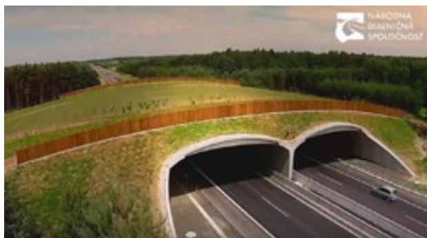
Obr. 6.36 V případech, kdy nejsou k dispozici mosty, které by bylo možné upravit, aby sloužily jako průchody pro faunu, je třeba vybudovat speciální průchody, které zajistí bezpečné křížení dálnice s migračním koridorem volně žijících živočichů. Nadchod na dálnici D2, Slovensko. © archiv NDS
