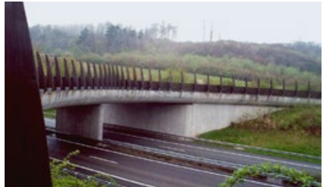
Obr. 10.24 Zelený most s nálevkovitým tvarem může být 40 m široký u vchodu ale pouze 10 m široký ve svém středu. Taková řešení znamenají finanční úsporu bez významného vlivu na funkčnost. Fotografie znázorňuje totožný nadchod jako obr. 10.23. Lucembursko. © Václav Hlaváč
