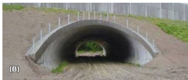
Obr. 10.37 Chování živočichů v blízkosti podchodu jasně poukazuje na fakt, že vnímají hluk způsobený projíždějícími vozidly (uložení mostní konstrukce) (A). Při výstavbě nových mostů je proto vždy nutné vybírat taková technická řešení, která minimalizují rušení hlukem v podmostí. Toho lze nejlépe docílit použitím vrstvy zeminy mezi mostní konstrukcí a samotnou komunikací (B). Ve srovnatelných podmínkách ale toto řešení bohužel vždy přináší redukcí rozměrů podmostí. © (A) Hnutí DUHA Olomouc, (B) AOPK ČR
