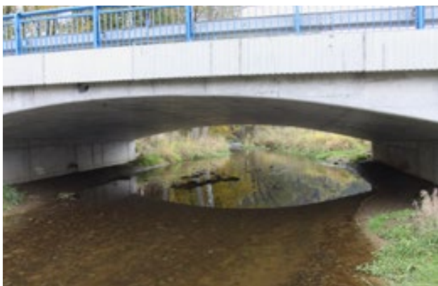
Obr. 10.8 Ptáci jako ledňáček říční, skorec vodní či konipas horský jsou schopni proletět pod mostem s indexem otevřenosti min. 1–2. Důležitá je i výška, která by měla být min. 2 m. V případě mostů s menšími rozměry létají ptáci typicky nad nimi a stávají se obětmi dopravy. © Václav Hlaváč
