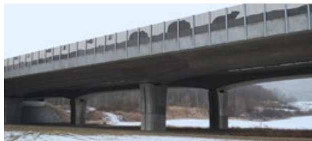
Obr. 10.36 Speciální podchody pro velké savce jsou budovány v místech, kde komunikace kříží migrační koridor. Dálnice D1, Bělá, Česká republika. © Martin Strnad
