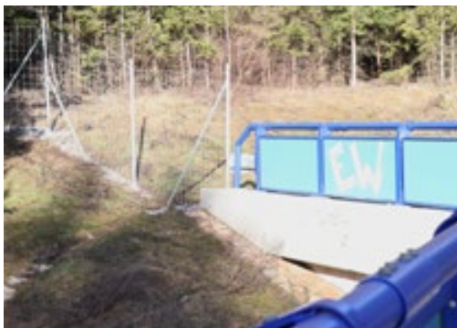
Obr. 10.27 Oplocení plynule napojené na ochranné stěny (zábradlí s výplní) slouží k navádění zvířete pohybující se podél dálnice ke vstupu na zelený most. Dálnice D1, Česká republika. © Václav Hlaváč
