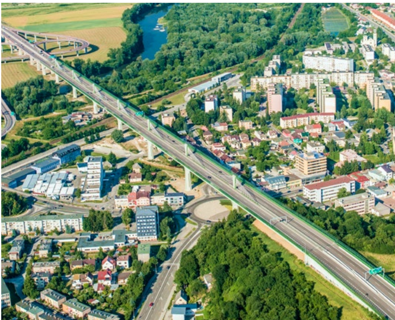
Obr. 9.11 Výstavba dálnice může narušit konektivitu zelených ploch také ve městech. Zajištění této konektivité je důležité pro řadu malých druhů živočichů. Dálnice D1 v Považské Bystrici, Slovensko. © archiv NDS
