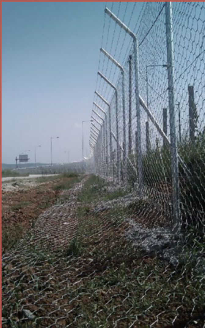
Obr. 10.55 – případová studie: Návrh plotu na ochranu medvědů (příklad z Řecka). © Lazaros Georgiadis/ARCTUROS
