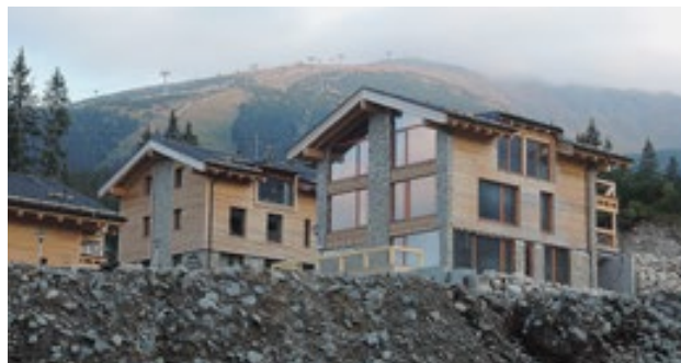
Obr. 6.4 Výstavba rekreačních středisek v horském prostředí s sebou vždy přináší rozvoj dopravní infrastruktury. Jasná, Nízké Tatry. © Barbara Immerová
