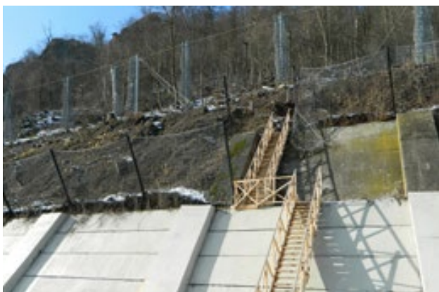
Obr. 9.13 Strmé svahy jsou zabezpečeny proti padajícím kamenům záchytným plotem nebo drátěným pletivem. Tato opatření mohou být nezbytná pro stabilizaci svahů, zároveň však zvyšují bariérový účinek a vedou ke ztrátě přírodních stanovišť na okrajích silnice. Je-li to možné, měla by být upřednostňována citlivější řešení. Rychlostní silnice R2, Zvolen, Slovensko. © Miroslav Jarný
