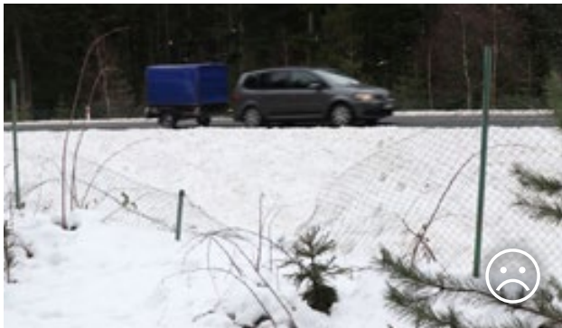
Obr. 10.56 Oplocení je často poškozené např. popadanými stromy nebo po nehodách. Zvěř obvykle takovéto otvory najde velmi rychle a dostává se tak do nebezpečné oblasti uvnitř oplocení. V případě vyrušení pak vyběhne přímo na komunikaci a stává se obětí dopravy. © Václav Hlaváč
