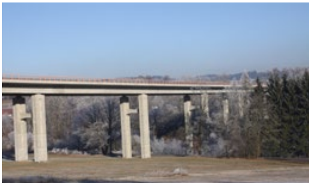
Obr. 10.34 Viadukty přes celá údolí umožňují průchod většině druhů živočichů, včetně velkých savců. V případě odpovídajících podmínek mohou propojovat celé ekosystémy. Česká republika. © Václav Hlaváč
