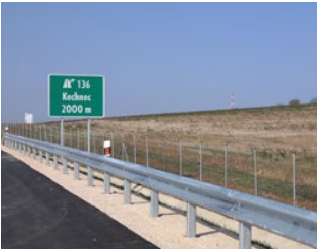
Obr. 9.20 Ploty obecně zabraňují úmrtnosti živočichů na silnicích, zvyšují však bariérový účinek infrastruktury. © archiv NDS
