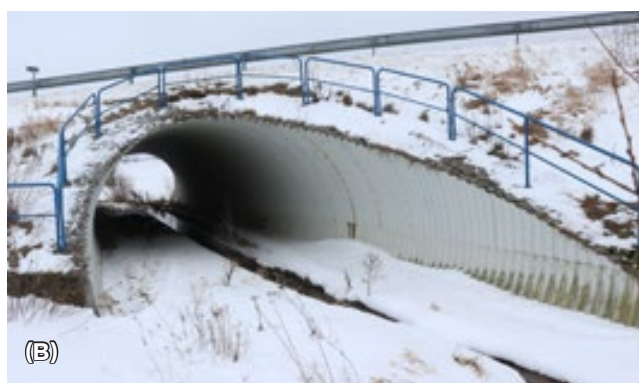
Obr. 10.42 Jako průchody pro malé volně žijící živočichy jsou snadno použitelné různé typy mostů přes vodoteče. Suché břehy po obou stranách v minimální šířce 0,5 m umožňují pohyb širokému spektru druhů až do velikosti jezevce. Ty by měly být zhotoveny z kamenné dlažby. Použití betonových chodníků je nevhodné, jelikož neumožňuje migraci obojživelníků (riziko vysychání). © Václav Hlaváč
