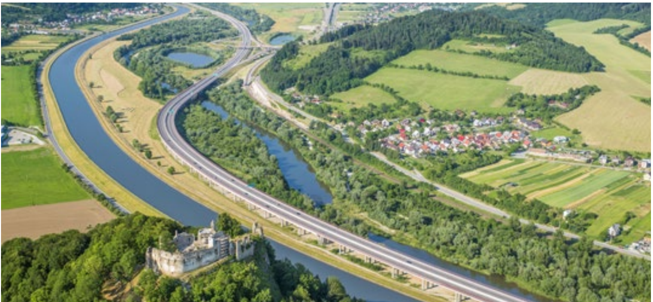
Obr. 5.8 Kumulace liniových struktur (umělý vodní kanál a dálnice) v údolí Váhu představuje nepropustnou bariéru pro většinu druhů. © archiv NDS
