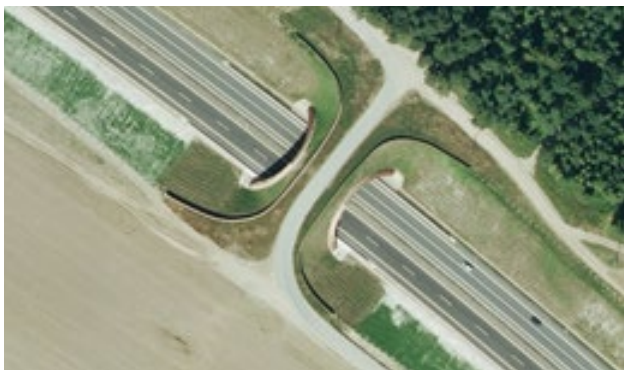
Obr. 6.34 Víceúčelové využití mostů je obvykle preferovaným řešením z hlediska nákladů. Jako vhodné se jeví spojování funkce průchodu pro faunu s funkcí mostu přes vodní toky nebo viaduktu. Na druhou stranu, rušná stezka přes zelený most může odradit velké savce od jeho využívání, čímž opatření ztrácí funkčnost. Poprad, Slovensko. © EUROSENSE s.r.o., 2010
