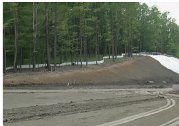
Obr. 8.6 Dočasné bariéry slouží k zamezení vstupu obojživelníků na staveniště. Živočichové by v takových případech měli být směrováni k vhodným průchodům nebo odchycení a přemístění do vhodného prostředí. © NaturaServís s r.o.
