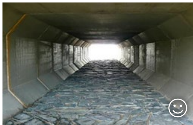
Obr. 10.5 V porovnání s trubním propustkem je pro migraci obojživelníků rámový propustek vždy lepším řešením. Povrch podchodu je pro tyto živočichy velmi důležitý, přičemž kamenná dlažba je vhodnou volbou. © Václav Hlaváč
