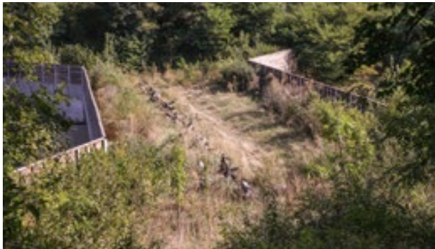
Obr. 10.25 Vhodně řešený zelený most. Mrtvé dřevo bylo spolu s výsadbou po stranách mostu instalováno během výstavby nadchodu. Následná sukcese vedla k vytvoření přirozeného napojení na okolní prostředí. Francie. © Václav Hlaváč
