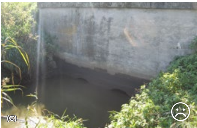
Obr. 10.46 Příklady nevhodných technických řešení. Propustky se vstupem, který je pro živočichy nepřekonatelný. © A a D) Lukáš Poledník, B) Václav Hlaváč, C) Jitka Matoušová
