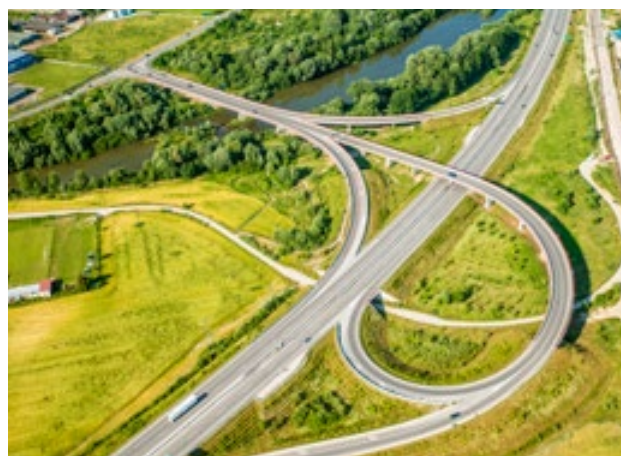
Obr. 5.9 Dopravní infrastruktura se v karpatských zemích rychle mění. © Václav Hlaváč, archiv NDS
