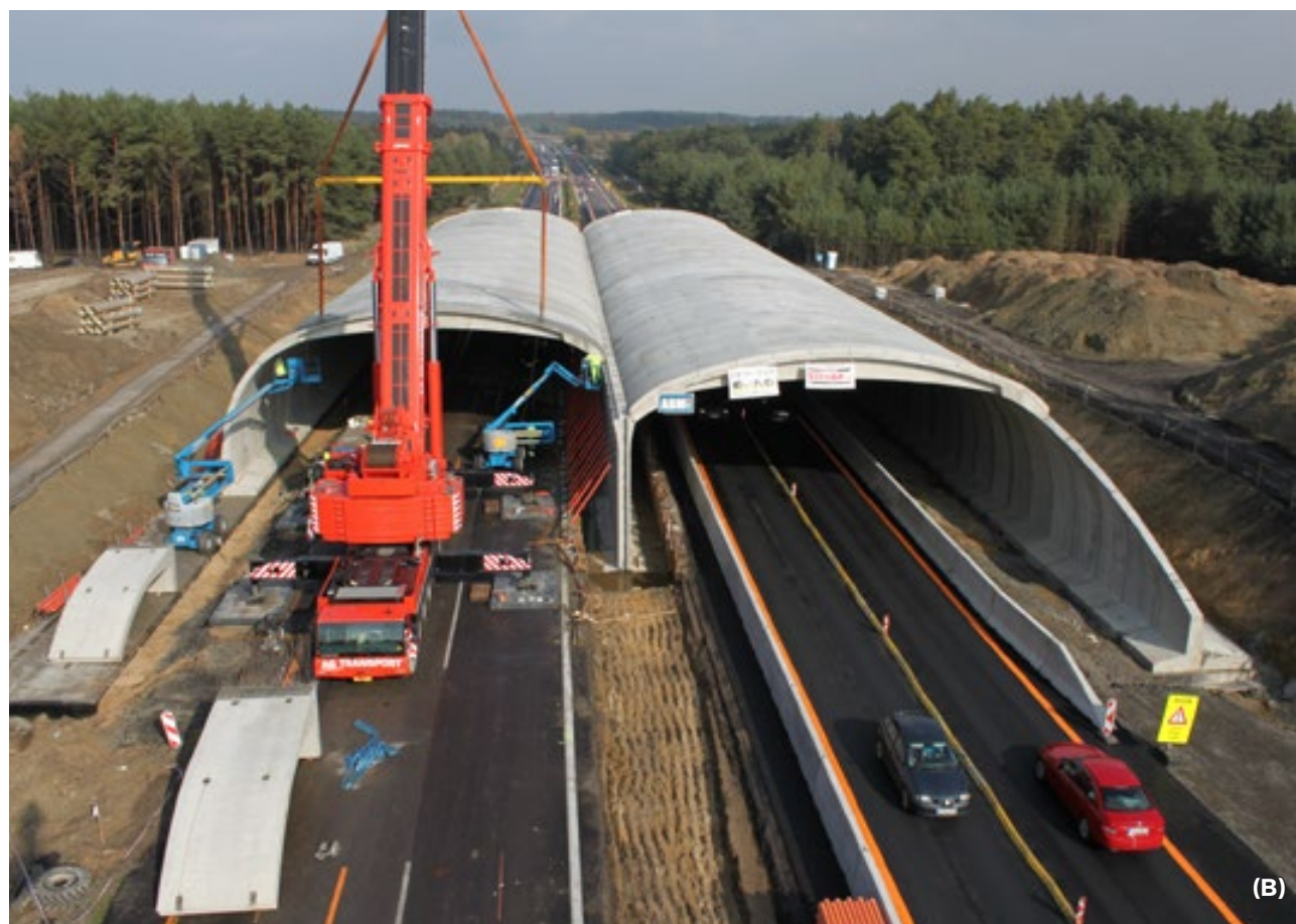
Obr. 9.16 A) Výstavba raženého tunelu ve Víšňové na dálnici D1, Slovensko. B) Výstavba hloubeného tunelu – zelený most poblíž Moravského Svätého Jánu, Slovensko. © archiv NDS
