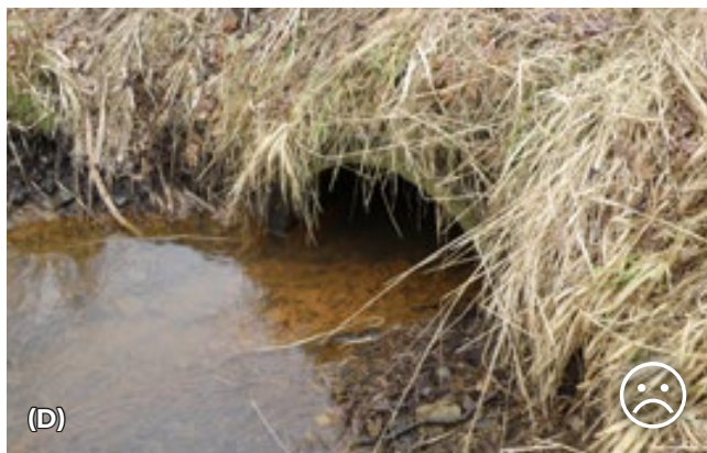
Obr. 10.46 Příklady nevhodných technických řešení. Propustky se vstupem, který je pro živočichy nepřekonatelný. © A a D) Lukáš Poledník, B) Václav Hlaváč, C) Jitka Matoušová
