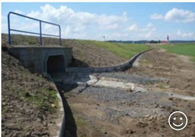
Obr. 10.58 Trvalé zábrany mají za cíl navedení migrujících obojživelníků ke vhodným podchodům. Vždy se budují na obou stranách komunikace – ve směru jarní migrace do vodních biotopů a též směrem zpět do biotopů terestrických. © Jaromír Maštera
