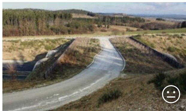
Obr. 10.29 Hlavní funkcí tohoto víceúčelového nadchodu s místní komunikací je umožnění pohybu volně žijících živočichů. Odpovídající úpravy jsou vhodné pro pohyb malých a středně velkých savců. Velcí savci však takovýto nadchod nevyužijí. Víceúčelové nadchody jsou tedy zcela nežádoucí v místech, kde dopravní infrastruktura kříží dálkový migrační koridor. Písek, Česká republika. © Václav Hlaváč
