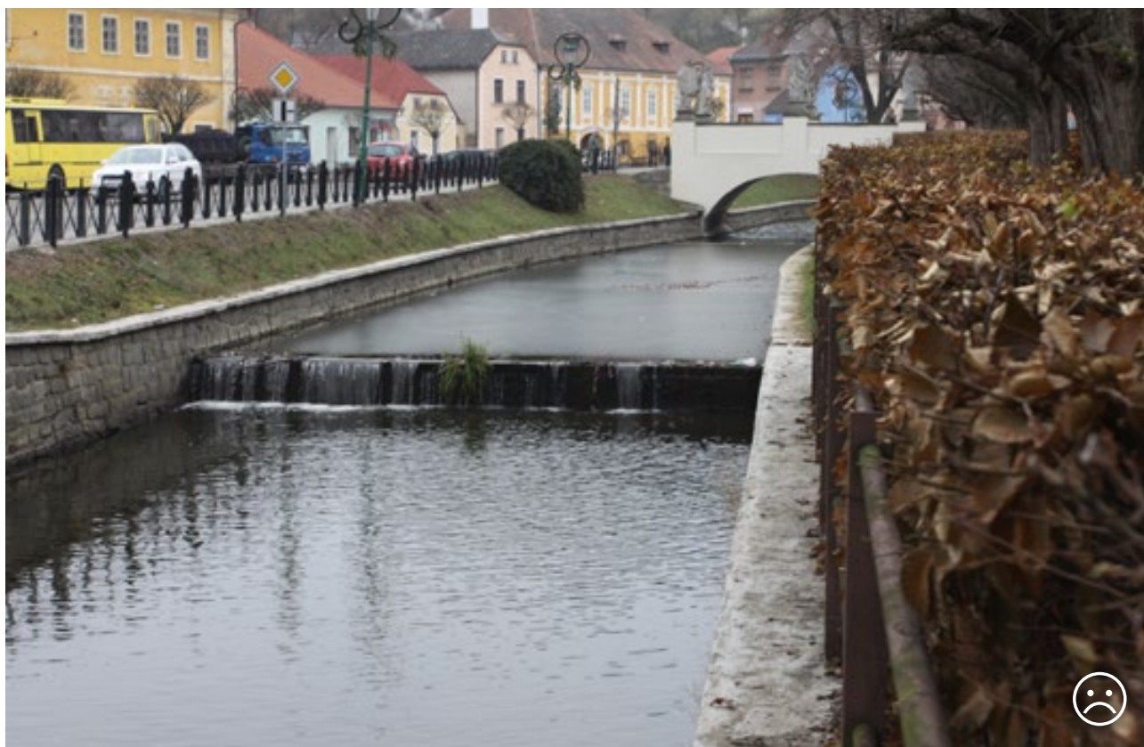
Obr. 10.15 Jez v kombinaci se svislým opevněním na obou březích vodního toku ve městě přinutí zvířata jako jsou vydra nebo bobr tyto překážky obcházet překonáváním silnice. © Václav Hlaváč
