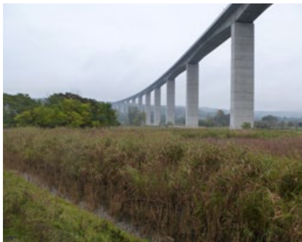
Obr. 9.6 Viadukty se obecně velmi osvědčily z hlediska minimalizace fragmentace krajiny a negativních dopadů na stanoviště pod nimi. Největší viadukt ve střední Evropě na dálnici M7 v Köröshegy poblíž jezera Balaton, Maďarsko. © András Weipert
