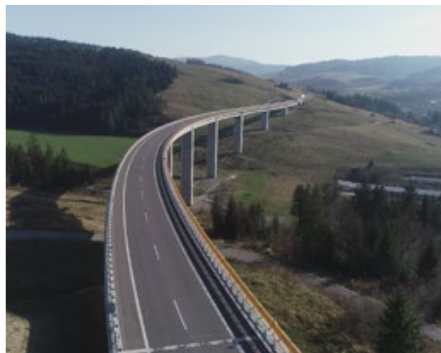
Obr. 9.3 Vedení silnice výše podél svahu umožňuje lépe řešit průchodnost pro živočichy (např. viadukty přes menší boční údolí), má však nevýhodu v podobě dopadu na dosud nedotčené přírodní oblasti. Úsek dálnice D3 Svrčinovec – Skalité, Slovensko. © archiv NDS
