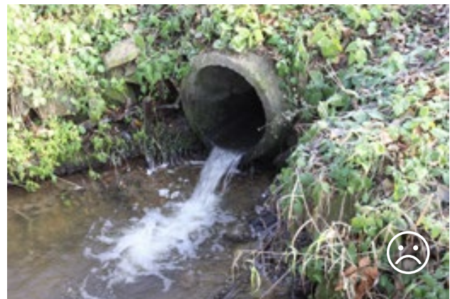
Obr. 10.3 Výškový stupeň vyústění propustky představuje migrační bariéru pro ryby, jako je např. střevle potoční nebo pstruh potoční. © Václav Hlaváč
