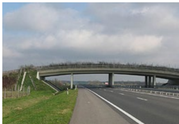
Obr. 6.42 Zelený most lze vybudovat i v rovinaté krajině, kde dálnice vede ve stejné úrovni s terénem. Spojení mostu s okolním terénem však zabírá větší plochu než v případě dálnice vedoucí v zářezu. Dálnice M7, Maďarsko. © Ábrahám László
