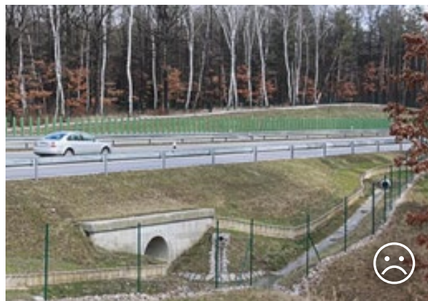
Obr. 10.45 Pokud je vstup do propustku na jedné straně mimo oplocení a na druhé straně uvnitř oplocení, živočichové zůstanou při průchodu uvězněni mezi oplocením a komunikací. V případě, kdy jsou oba vstupy do propustku oploceny, je takový propustek pro živočichy zcela nevyužitelný. © Václav Hlaváč
