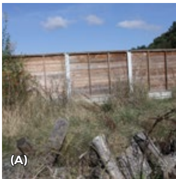
Obr. 10.28 Protihlukové stěny efektivně omezují rušivé vlivy na zelených mostech. Mohou být vybudovány ze dřeva (A), plastu, nebo jako kamenné stěny (B). Kamenné stěny jsou nákladnější a představují vyšší zátěž na most, avšak vytvářejí nové biotopy (např. pro plazy) a jejich životnost je prakticky neomezená. © Václav Hlaváč
