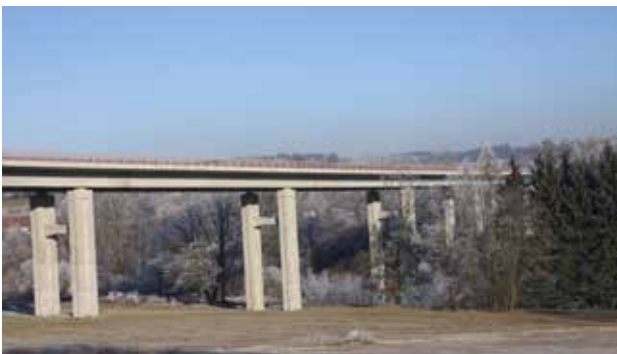
Рис. 10.34. Віадуки виконують роль переходів для більшості видів тварин, включаючи великих ссавців. Вони повністю забезпечують функціонування екологічного коридору, підтримуючи зв'язок екосистем між обома сторонами автодороги. Чеська Республіка. © Вацлав Главач
