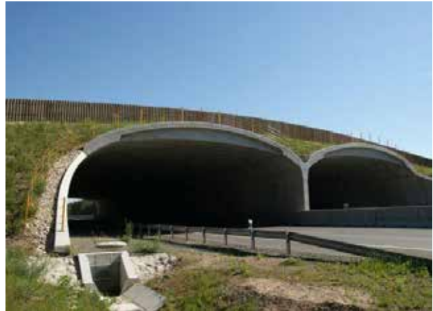
Рис. 7.6. Одним із базових принципів Протоколу про сталий транспорт є мінімізація негативного впливу транспорту на природу. Зелений міст «Моравський святий Ян» на автомагістралі D2 (Словаччина) був побудований з метою відновлення міграції тварин у межах екокоридору «Альпи-Карпати», який був фрагментований чисельними дорогами й поселеннями між Альпами та Карпатами. © Душан Валаховіч
