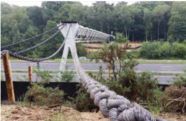
Рис. 10.16. Приклад спеціального переходу для ссавців, що живуть на деревах. Автомагістраль A12 (Utrecht - Arnhem, Wofheze, Нідерланди). Перехід адаптований для використання куницею. Він містить «прогулянкову доріжку», яку з'єднують товсті канати з обох кінців дороги. Використання цього переходу такими тваринами як куниця підтверджено фотопастками. © Ян Віллем Бургманс, Heijmans Infra
