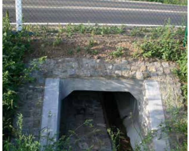
Рис. 9.5. Прямокутні кульверти є придатними для переходів тварин, вони відносно легко будуються у межах рівнинного ландшафту. © Лукаш Поледнік
