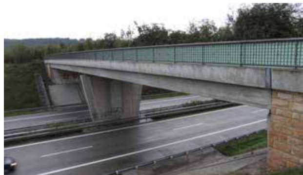
Рис. 10.30. Міст з лісовою стежкою був розширений на 2 м з кожної сторони і засаджений кущами. Негативний вплив дороги усувається захисними стінами (суцільною огорожею). Такий багатоцільовий перехід може використовуватися меншими видами ссавців (лисицею або борсуком), а також дрібними птахами, кажанами тощо. Німеччина. © Вацлав Главач
