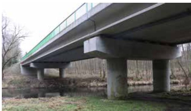
Рис. 6.41. Належно спроектований міст та широкі береги забезпечують вільний рух водних, напівводних і наземних тварин. © Вацлав Главач
