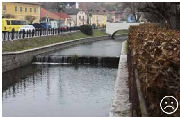
Рис. 10.15. Водозлив у поєднанні з вертикальними стінами з обох боків водотоку змушує тварин обходити такі місця. Таким чином, тварини змушені перетинати дороги. © Вацлав Главач
