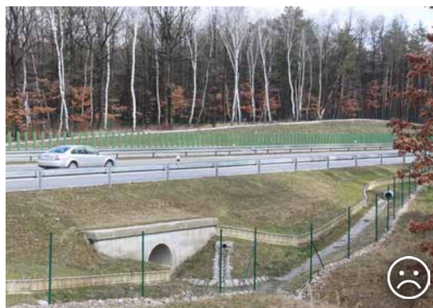
Рис. 10.45. Якщо вхід до кульверта знаходиться за межами обгородженої території, а на іншому узбіччі всередині обгородженої території, то в такому випадку тварини, що використовують такий підземний перехід, потрапляють в пастку між огорожею й дорогою. У випадку, якщо обидва входи знаходяться в межах обгородженої території, підземний перехід взагалі не може функціонувати. © Вацлав Главач
