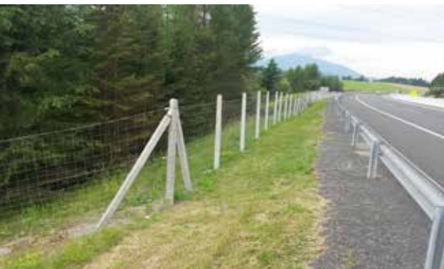
Рис. 6.19. Огорожі запобігають виходу тварин на дорогу, проте вони також суттєво збільшують бар'єрний ефект об'єктів транспортної інфраструктури. Огорожі треба встановлювати у місцях, де тварини мають альтернативну можливість перетину цих об'єктів, використовуючи безпечні переходи. © Архів NDS
