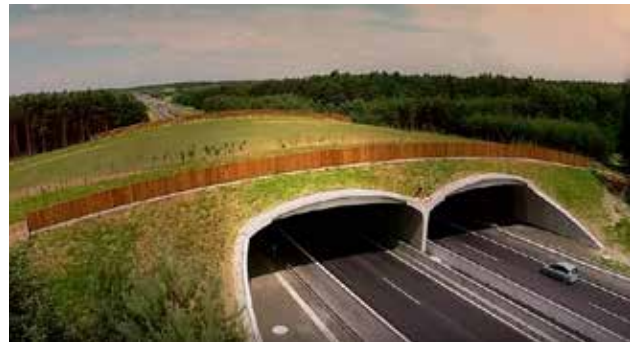
Рис. 6.36. У випадках, коли не існує мостів, які можуть бути пристосовані для використання їх дикими тваринами, у цьому випадку необхідно побудувати спеціальні переходи для безпечного перетину тваринами. Надземний перехід, автомагістраль D2, Словаччина. © Архів NDS
