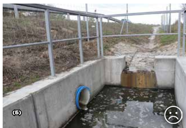
Рис. 9.17. Невеликий резервуар є пасткою для багатьох дрібних тварин, особливо, коли рівень води в ньому падає. Доцільно конструювати такий резервуар як модель природного оселища або, принаймні, з однією похилою стінкою, щоб тварини могли пройти його. D1, Чеська Республіка. © Петр Андел (А), Вацлав Главач (Б)
