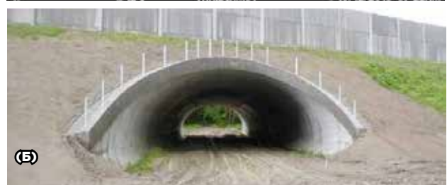
Рис. 10.37. Поведінка тварин, зображена на фото, вказує на те, що вони чутливі до шуму, що виникає при проходженні транспортних засобів - (А). Тому, будуючи нові мости, завжди необхідно обрати рішення, яке мінімізує шумове забруднення. Шум під мостом можна усунути завдяки додатковому шару ґрунту між мостом і дорогою (Б). Це рішення завжди призводить до зменшення розмірів мосту. © (А) Friends of the Earth Czech Republic, (Б) Nature Conservation Agency of the Czech Republic
