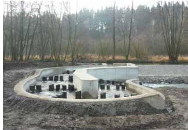
Рис. 10.49. Перехід для риб, призначений для подолання греблі висотою 1,3 м і загальною довжиною 40 м. Чеська Республіка. © Богуміла Єрмова
