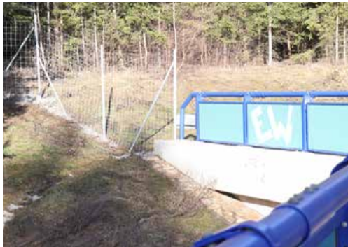
Рис. 10.27. Огорожі, які легко з'єднуються із захисними стінами, спрямовують тварин у правильному напрямі. D1, Чеська Республіка. © Вацлав Главач
