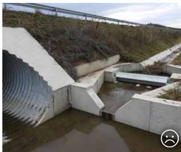
Рис. 9.18. Кульверти більшого діаметра завжди повинні забезпечувати міграцію фауни під автомагістраллю. У цьому випадку стік технічно розташований таким чином, що повністю виключає можливість використання кульверта як переходу для міграції фауни. Більше того, він слугує смертельною пасткою для дрібних тварин. © Вацлав Главач
