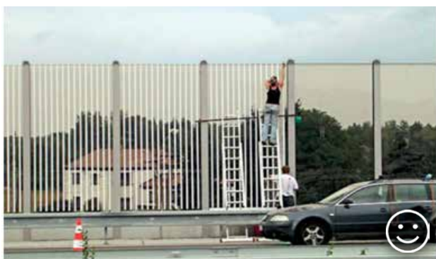
Рис. 10.62. Процес установки додаткових спеціальних смуг до шумозахисної стіни на автомагістралі D47 в Чехії. У 2008 році майже 200 мертвих птахів були знайдені на ділянці протяжністю лише 1 км цієї автомагістралі між Богумином і Островою протягом 6 місяців. Цей рівень смертності знизився практично до нуля після оснащення стін смугами. © Ян Майєр
