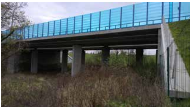
Рис. 10.38. Природні поверхні значно покращують міграційну функціональність підземного переходу. Захисна стіна обабіч дороги також сприяє кращому використанню переходу тваринами завдяки зниженню негативного впливу транспорту (шуму). Прозора стіна повинна бути також адаптованою для птахів. Чеська Республіка. © Nature Conservation Agency of the Czech Republic
