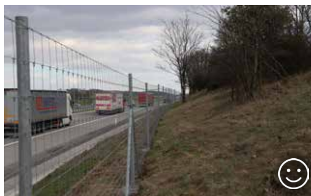
Рис. 10.53. Правильно розміщена огорожа. Дерева й чагарники є привабливим середовищем існування для низки видів, тому їх треба садити за межами обгородженої території. © Вацлав Главач
