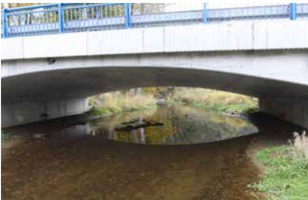
Рис. 10.8. Такі птахи, як рибалочка, пронунок і плиска гірська здатні літати під мостом з індексом відкритості не менше 1 – 2. Висота також важлива – вона повинна бути не менше 2 м. У випадку мостів з меншими розмірами птахи зазвичай літають над ними і часто стають жертвами дорожнього руху. © Вацлав Главач
