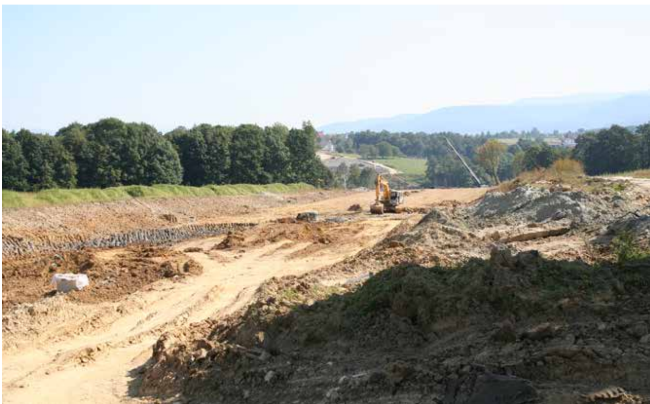
Рис. 4.1. Будівництво доріг у гірських умовах часто призводить до знищення цінних типів оселищ. Дорога S52 між м. Скочув і м. Б'ельсько-Бяла. © Іво Достал
