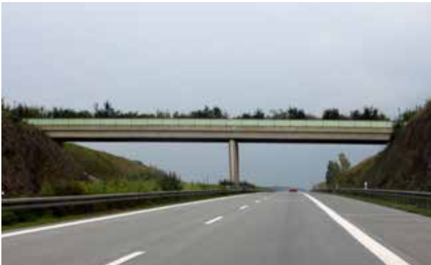
Рис. 10.18. Ґрунтова дорога над автомагістраллю, розширена смугами кущів є чудовим переходом для дрібних видів кажанів. Міст також використовується іншими видами тварин. Німеччина. © Вацлав Главач
