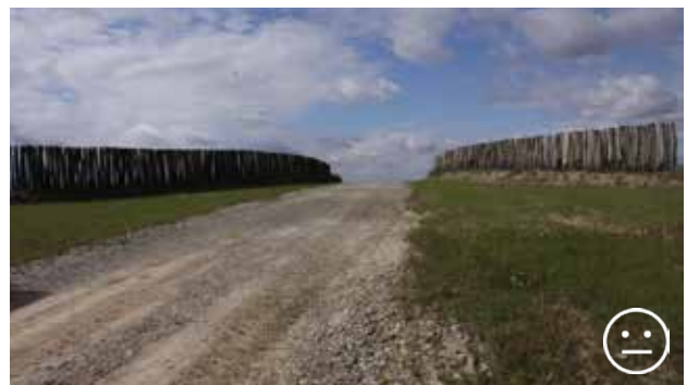
Рис. 10.32. Багатоцільовий надземний перехід може лише частково використовуватись тваринами. Відповідні укриття й мікроєлища для дрібних тварин відсутні, так само, як кущі для великих тварин. Укриття є надзвичайно необхідними, оскільки без них тварини почуваються в небезпеці, що суттєво ускладнює перетин такого переходу. © Вацлав Главач
