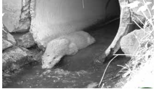
Рис. 6.35. Кульверти з відповідною конструкцією можуть слугувати переходами для багатьох тварин. Прямокутна форма завжди є кращим рішенням. Циліндрична форма не є оптимальним рішенням, але видри здатні використовувати такі кульверти в моменти зниження швидкості потоку води. © Валцлав Главач (фото зроблене фотопасткою)
