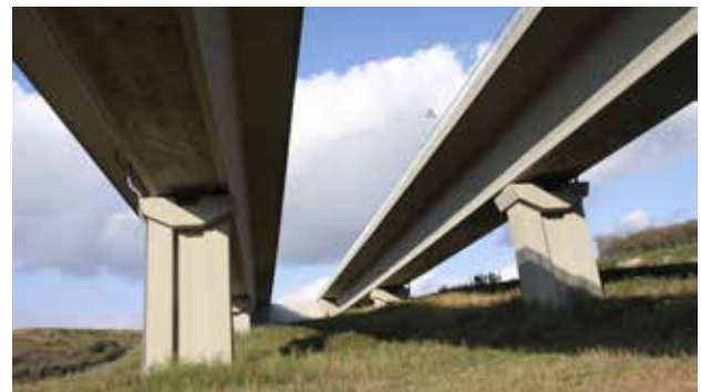
Рис. 10.35. Віадук має роздільну конструкцію, тому поверхня під мостом має достатню кількість світла і опадів. Це дає змогу краще з'єднати відповідні типи оселищ. З іншого боку, загальна площа ушкодженої будівництвом ділянки більша порівняно з уніфікованою конструкцією, що відповідно посилює вплив шуму під мостом. Угорщина. © Вацлав Главач
