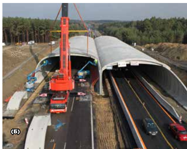
Рис. 9.16. А) Будівництво тунелю способом буріння, автомагістраль D1, Višňové, Словаччина. Б) Будівництво тунелю відкритим способом – зелений міст біля Moravský Svätý Ján, Словаччина. © Архів NDS
