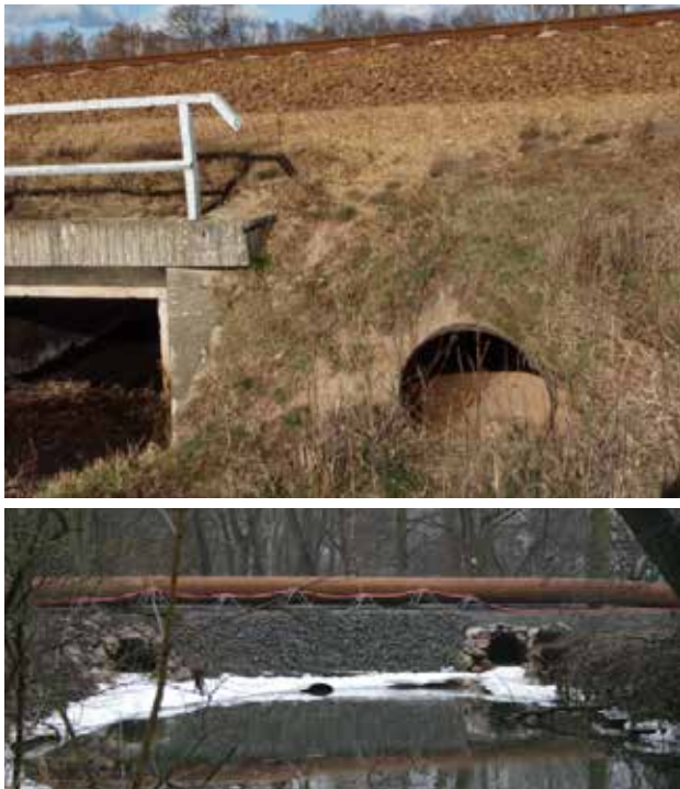
Рис. 10.47. Тунелі для видр є відповідним рішенням у тих місцях, де міст є непрохідним для цих тварин або де об'єкти транспортної інфраструктури проходять над водоймою або водосховищем. © Лукаш Поледнік
