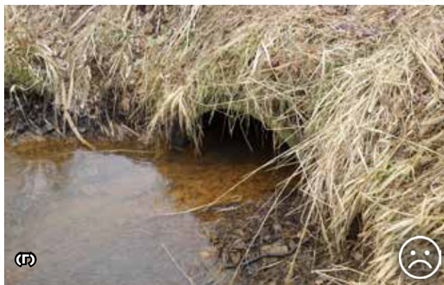
Рис. 10.46. Приклади неправильних технічних рішень для кульвертів щодо міграції тварин, в яких конструкція входу не дозволяє проникати тваринам, тим самим унеможлиблює їхнє переміщення через такі переходи. © Лукаш Поледнік - А), - Б), - Г) Вацлав Главач - Б), Ітка Ветровцова - В)
