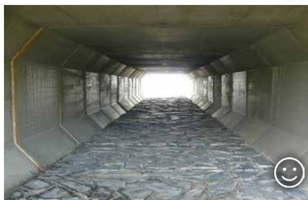
Рис.10.5. Кульверти прямокутної форми та з кам'яною бруківкою є найкращим рішенням для підтримання міграції земноводних. © Вацлав Главач
