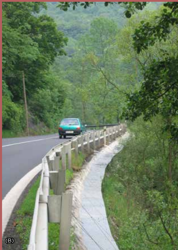
Рис. 10.7. Спеціальний бар'єр для запобігання загибелі полоза ескулапового, Чехія © Фото Zamenis, z.s., Джерело: Musilová et al. 2010
