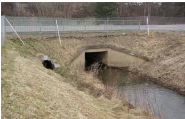
Рис. 10.14. У випадку, якщо неможливо налаштувати вже збудований міст як перехід для фауни, можна додатково створити окремий тунель для видр. © Лукаш Поледнік
