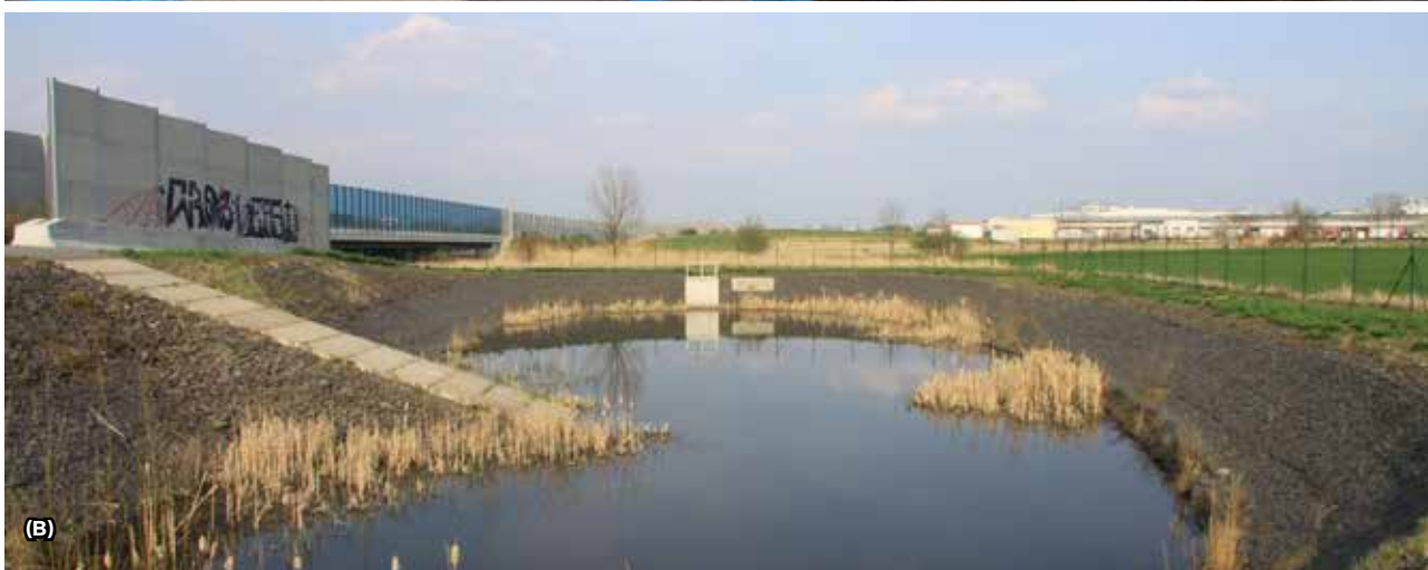
Рис. 4.12. Резервуари для збору води часто є обов'язковими складовими будівництва доріг. Вони можуть бути пастками для багатьох видів тварин. Цей резервуар обладнаний перилами, проте, незважаючи на це, в ньому знайдено втоплену сарну європейську, а також інші дрібніші тварини (А). Необхідно проектувати резервуари з накриттям або такими, щоб тварини, які потрапили в нього, могли вибратися. Оптимальним рішенням є розроблення резервуарів за подібністю до відповідних природних типів оселищ (В) © Петр Андел
