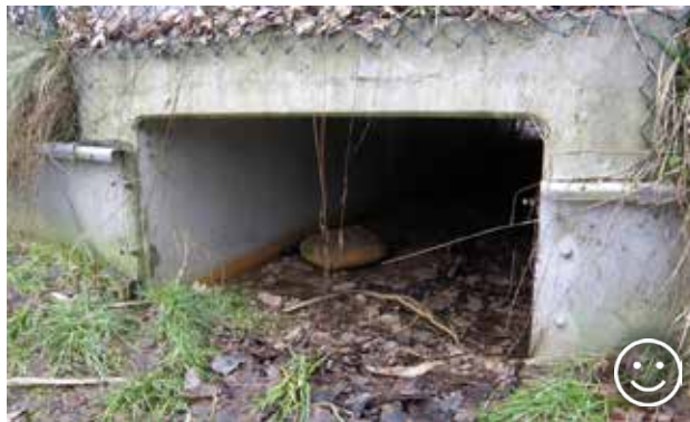
Рис. 10.43. Кульверт прямокутної форми є хорошим рішенням для амфібій, плазунів і ссавців середнього розміру. © Лукаш Поледнік
