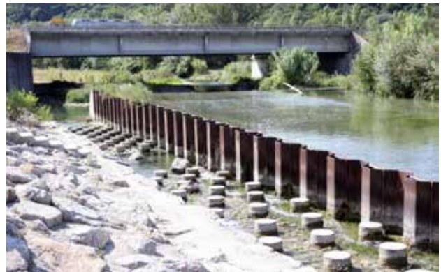
Рис.10.50. Перехід для риб біля Ліона, Франція, де в результаті будівництва доріг був створений вертикальний уступ у водотоці. Перехід розміщується безпосередньо у водотоці. Його також використовують видри. © Вацлав Главач
