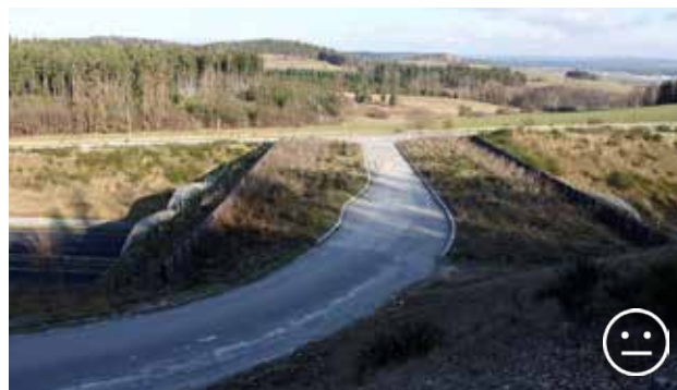
Рис. 10.29. Багатоцільовий перехід з місцевою доріжкою, де основною метою є забезпечення руху тварин. Він підходить для дрібних і середніх ссавців. Багатоцільові переходи небажані в місцях, де інфраструктура перетинає великі міграційні коридори. Пісек, Чеська Республіка. © Вацлав Главач
