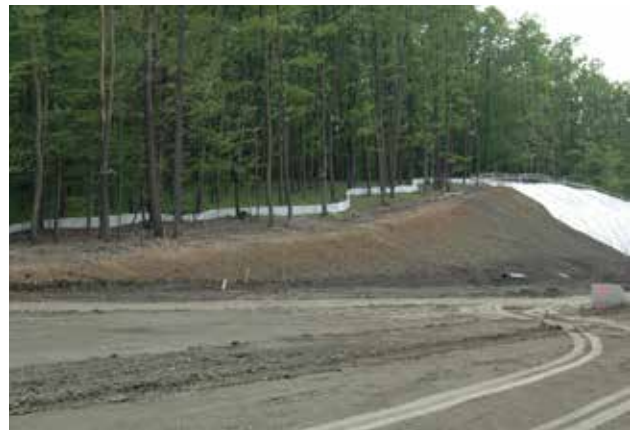
Рис. 8.6. Тимчасові перешкоди використовують для запобігання появи амфібій на будівельному майданчику. У такий спосіб ці тварини повинні направлятися до відповідних переходів або їх потрібно ловити й перевозити до відповідних для їх поширення місць. © Naturaservis, Ltd.
