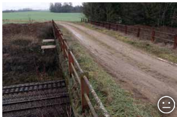
Рис.10.2. Багатоцільовий надземний перехід над двоколійною залізницею Прага – Брно (Чехія) завширшки 7 м і завдовжки 35 м. Трав'яні смуги по краях переходу використовуються різними видами безхребетних. Завдяки глинистій природній поверхні перехід також регулярно використовують косулі, зайці, лисиці, піщані ящірки тощо. © Вацлав Главач
