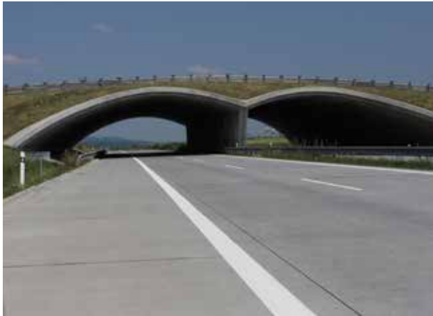
Рис. 9.7. Великі ссавці можуть мігрувати зеленими мостами, для будівництва яких потрібні ширші ділянки території з метою об'єднання поверхні мосту із навколишнім ландшафтом. © Вацлав Главач
