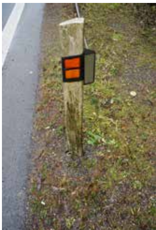
Рис.12.19. Штучний світловий засіб стримування тварин, обладнаний на придорожному стовпі. Відбивний елемент відбиває світло від машин, що наближаються на придорожній ділянці та попереджає тварин про небезпеку. Зменшення загибелі тварин від такого світлового бар'єру досі достовірно не підтверджено. Бескиди, Чеська Республіка. © Мартін Стрнад
