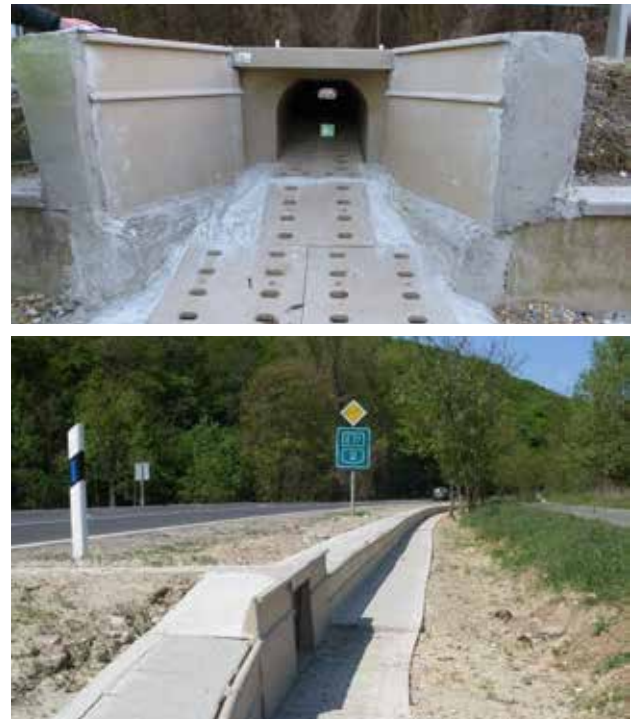
Рис. 10.48. Тунель для земноводних – оптимальне рішення для подолання тваринами вузьких доріг нижчої категорії. Бар'єри, які спрямовують тварин до проходу, є необхідною умовою для належного функціонування. © Андраш Вайперт
