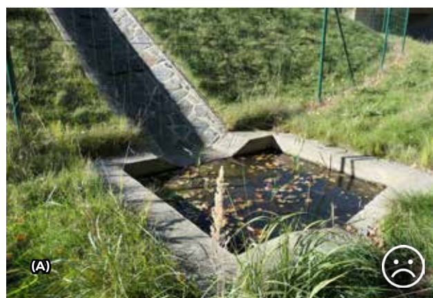
Рис. 9.18. Кульверти більшого діаметра завжди повинні забезпечувати міграцію фауни під автомагістраллю. У цьому випадку стік технічно розташований таким чином, що повністю виключає можливість використання кульверта як переходу для міграції фауни. Більше того, він слугує смертельною пасткою для дрібних тварин. © Вацлав Главач
