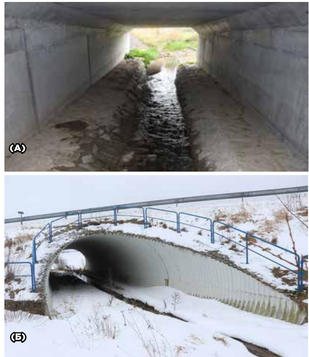
Рис. 10.42. Різні типи мостів через невеликі водотоки використовують у вигляді переходів для дрібних тварин. Сухі береги шириною не менше 0,5 м забезпечують можливість міграції тварин під дорогами. Береги повинні бути виготовлені з кам'яної бруківки. Потрібно уникати використання бетону, оскільки цей матеріал перешкоджає міграції земноводних. © Вацлав Главач
