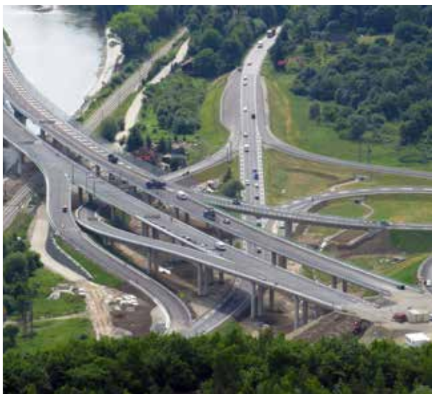
Рис. 9.15. Будівництво транспортних вузлів вимагає великих територій. При їхньому розробленні треба уникати руйнування цінних типів оселищ та створення ділянок, які можуть слугувати екологічними пастками для багатьох видів тварин. Перехрестя поблизу Врутки, Словаччина. © Томаш Флайс
