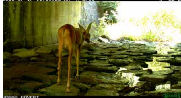
Рис. 10.20. Сарна європейська використовує підземні переходи з індексом відкритості більше 1. На рисунку зображений підземний перехід під залізницею шириною 5 м, висотою 3 м і довжиною 15 м (OI = 1). © Вацлав Главач, фотопастка
