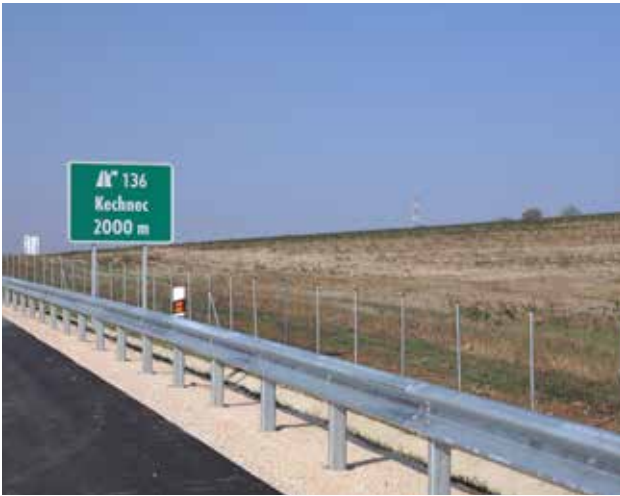
Рис. 9.20. Огорожі запобігають загибелі тварин, але збільшують бар'єрний ефект щодо об'єктів транспортної інфраструктури. © Архів NDS
