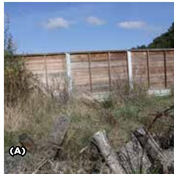
Рис. 10.28. Захисні стіни ефективно зменшують негативний вплив на зелених мостах. Вони можуть бути виготовлені з дерева (А), пластику або у вигляді кам'яних стін (Б). Кам'яні стіни мають недоліки, оскільки є затратними і створюють сильніше навантаження на конструкцію мосту. Проте ці стіни також мають переваги – необмежений час експлуатації та створення нових оселищ (наприклад, для рептилій). © Вацлав Главач
