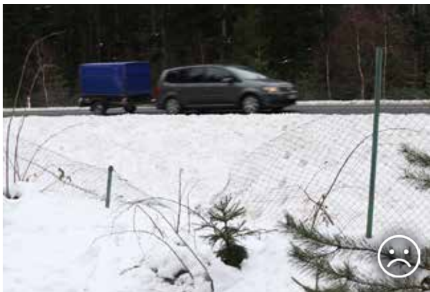
Рис. 10.56. Огорожі часто пошкоджуються поваленими деревами або транспортними аваріями. Тварини зазвичай знаходять ці ділянки дуже швидко і потрапляють у небезпечну зону між огорожами. Як наслідок, вони перебігають дорогу і стають жертвами руху. © Вацлав Главач
