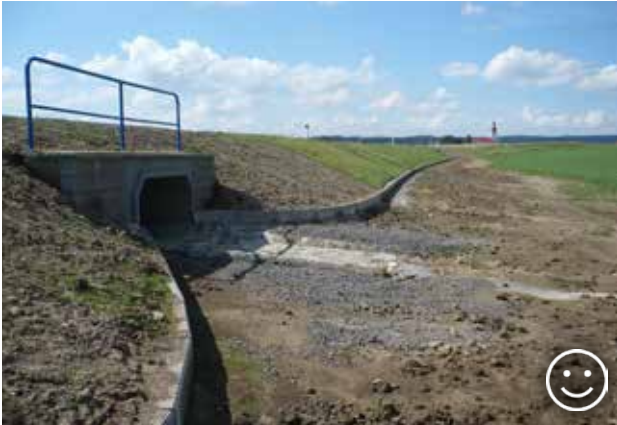
Рис. 10.58. Постійні бар'єри будують з метою скеровувати мігруючих амфібій до відповідного переходу. Вони завжди побудовані з обох сторін – у напрямі весняної міграції до водних середовищ і в протилежному напрямі – від водних до наземних типів оселищ. © Яромир Маштера
