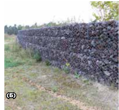
Рис. 10.28. Захисні стіни ефективно зменшують негативний вплив на зелених мостах. Вони можуть бути виготовлені з дерева (А), пластику або у вигляді кам'яних стін (Б). Кам'яні стіни мають недоліки, оскільки є затратними і створюють сильніше навантаження на конструкцію мосту. Проте ці стіни також мають переваги – необмежений час експлуатації та створення нових оселищ (наприклад, для рептилій). © Вацлав Главач
