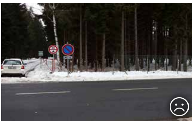
Рис. 10.52. Огорожа, перервана лісовою стежкою. Ця дорога першого класу була обгороджена через велику кількість зіткнень із тваринами. На жаль, через наявність лісових доріг огорожа не є цілісною. Число нещасних випадків у спостережуваному районі зросло ще більше після встановлення огорожі, тому що тварини потрапляли всередину обгородженої території без можливості вийти з неї. © Вацлав Главач
