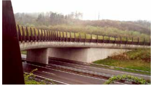
Рис. 10.24. Ширина витягнутого зеленого мосту на входах може бути шириною 40 м, а всередині всього лише 10 м. Це вигідне економічне рішення без значного впливу на функціональність міграційного екокоридору. На рисунку зображений той самий перехід, що й на рис. 10.25, Люксембург. © Вацлав Главач
