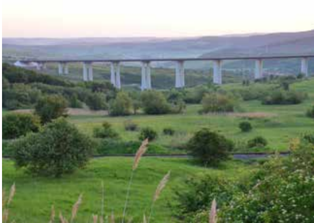
Рис. 9.8. Віадуки - кращий варіант, ніж насипи, оскільки територія під ними є вільною і тварини можуть мігрувати. Віадук Акілю на автомагістралі А1 (Бухарест - Надлак) у Румунії, округ Сібіу. © Тібор Сос
