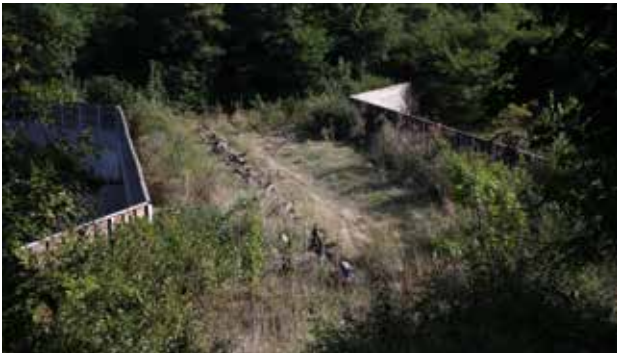
Рис. 10.25. Під час будівництва використовували мертву деревину і насадження кущів з обох боків дороги, що привело до хороших результатів щодо підтримки функціонування екокоридору разом із прилеглими лісовими масивами. Франція. © Вацлав Главач
