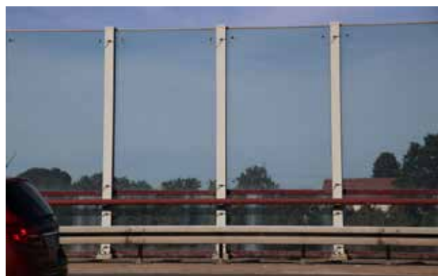
Рис. 10.60. Вертикальні смуги або дротяна сітка в склі є надійним захистом від травм й загибелі птахів і водночас є прийнятним архітектурним рішенням. © Вацлав Главач
