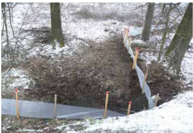
Рис. 10.57. Під час весняних міграцій встановлення тимчасових бар'єрів запобігає виходу земноводних на дорогу і водночас скеровує їх до безпечних переходів. Після закінчення міграцій необхідно усунути перешкоди. © Jaromír Maštera i Michal Ambros
