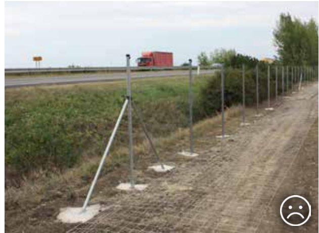
Рис. 9.24. Високоросла рослинність між дорогою й огорожею приваблює тварин, оскільки вона часто є єдиним осередком рослинності в сільськогосподарських ландшафтах інтенсивного використання. Крім того, огорожа за деревами, яку не видно з боку дороги, спричинює ще вищий ризик зіткнень автомобілів із тваринами. © Архів NDS
