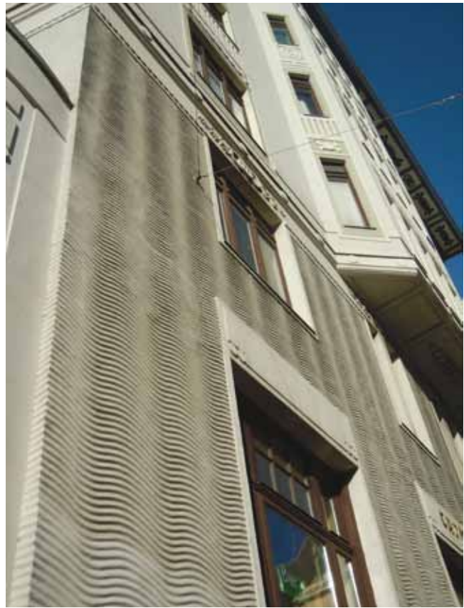
7. Oskar Marmorek, “Rüdigerhof”, 20 Hamburgerstraße, 1050 Vienna, 1902, combed plaster
