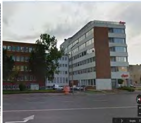
Upravna zgradba EONa + mreža (Debrecen, HU)
