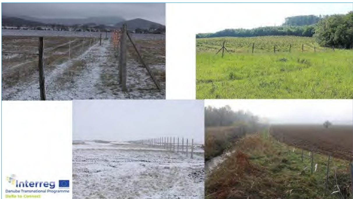
Obr. č. 6: Ukážka bariérového prvku oplotenia v kategórii priechodnosti „C1“. Ide o stabilné a pevné oplotenia s výškou cca. 2 m, ktoré sú pre väčšinu lesnej zveri prakticky neprekonateľné. Na obrázku sú zobrazené
