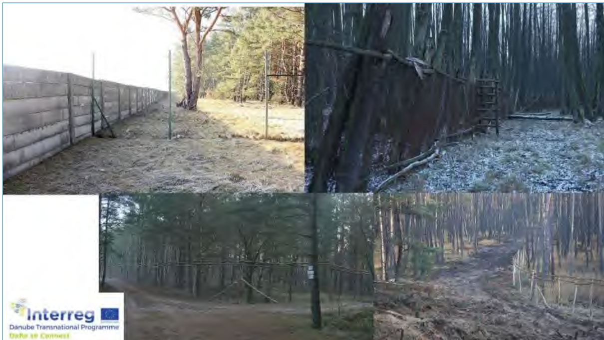
Obr. č. 7: Ukážka bariérových prvkov oplotení v kategórii priechodnosti „C1“. Ide o stabilné a pevné oplotenia s výškou nad 2 m, ktoré sú pre väčšinu lesnej zveri úplne neprekonateľné. Na obrázku sú zobrazené oborové oplotenia, ktoré sú často doplnené o elektrické zabezpečenia oplotení. V ľavom hornom rohu je zobrazené oplotenie letiska (betónový plot) a naň nadväzujúci vysoký plot vo Vojenskom obvode Záhorie s celkovou dĺžkou presahujúcou 8 km.
