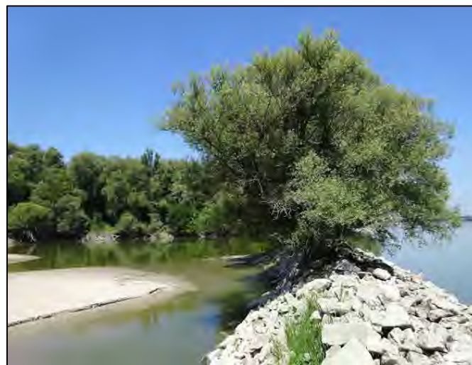
2.1. kép – Kőszórással megerősített Gabriella-sziget [dunaiszigetek.blogspot.com]
