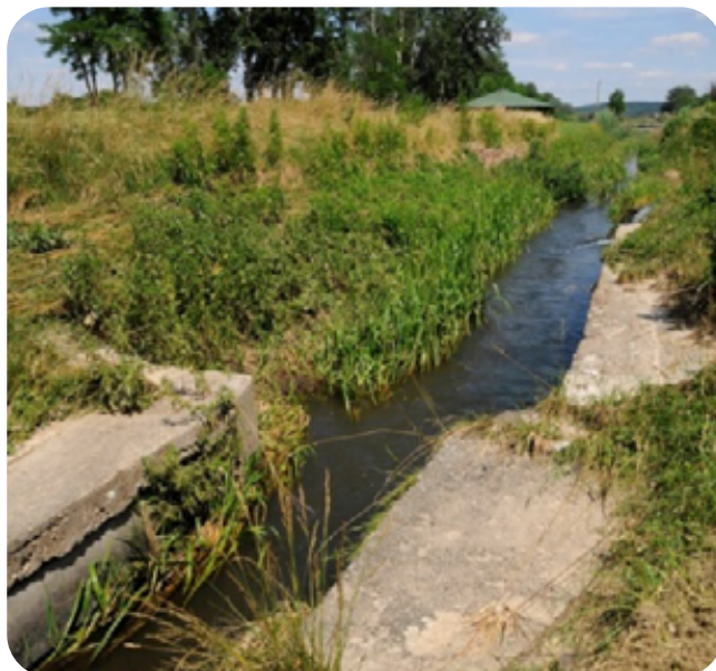
16. kép: A Pécel határán véget érő kibetonozás
