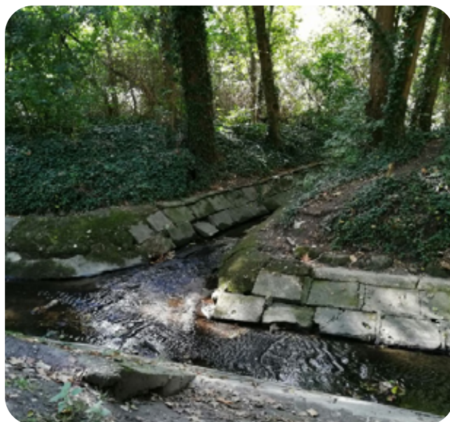
4. kép: A Rákospatak gödöllői szakaszán mellékág becsatlakozása
