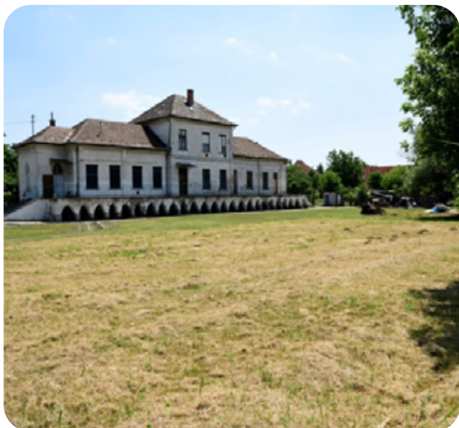
14. kép: Süllyedő kastély a Rákoscába utcánál
