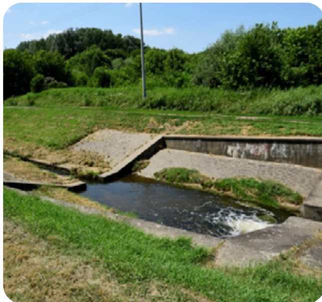
15. kép: A Rákos-patak egyik hordalékfogója
