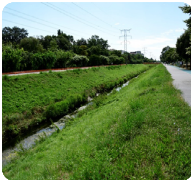
26. kép: A Rákos-patak kiépített betonmedre
