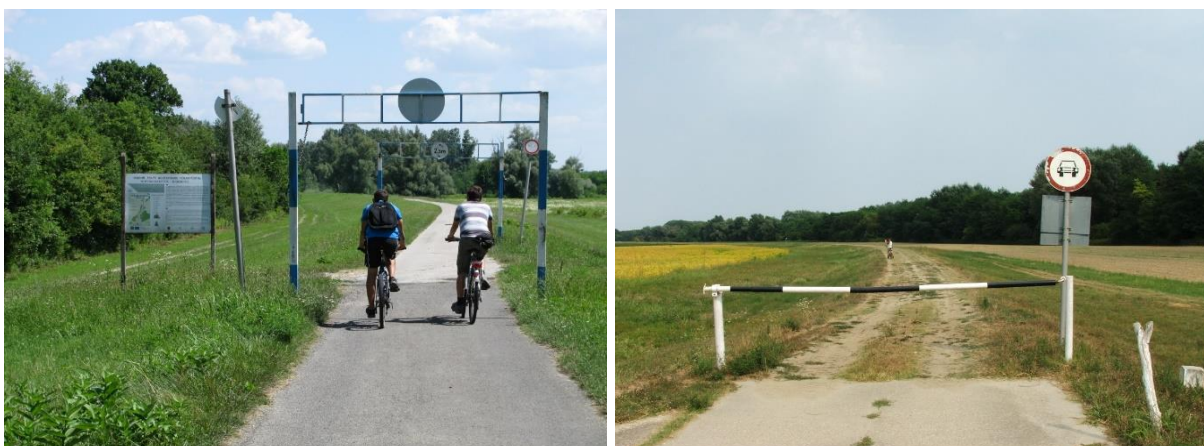
44-45. Figures: Felsőszentmárton-Drávasztára dyke, asphalt (left); Drávasztára-Mailáthpuszta dyke ((right)
