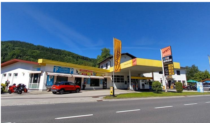
Picture 12 Tankstelle & Radverleih Straß, Engelhartzell
