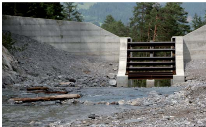
77. ábra: Újonnan épített gát Feistritzbach-nál (Felső-Dráva, Ausztria). A régi gátat eltávolították és a medret megtisztították a felhalmozott hordaléktól
