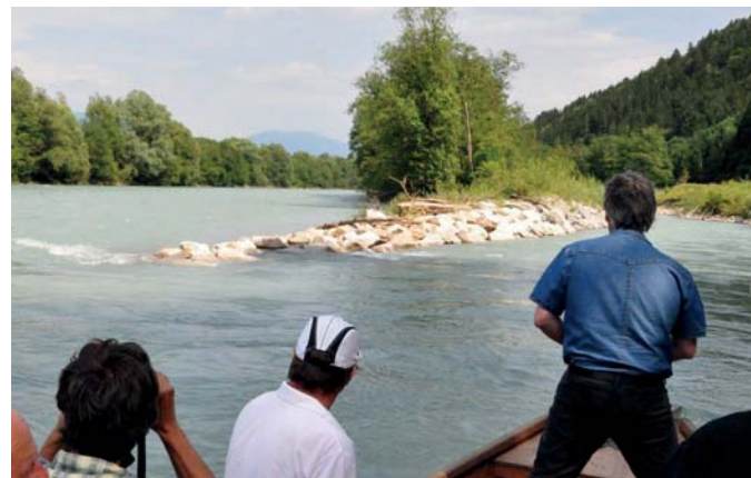
90. ábra: Ívelt sarkantyúkkal a főmeder felől a vezérárokba terelhető a víztömeg (Felső-Dráva, Ausztria)
