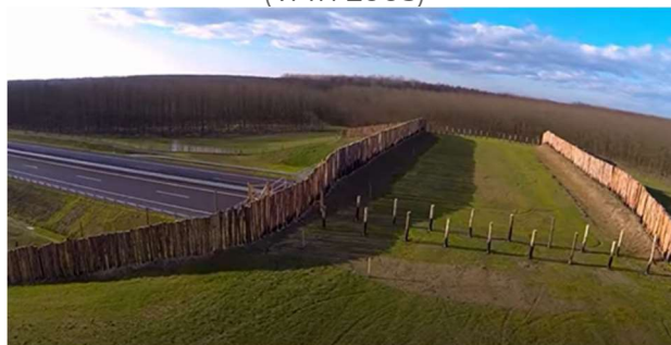
11. ábra Meglévő vadon élő állatok felüljárója az M3-as autópályán Magyarországon (Forrás: https://magyarepitok.hu/vasarosnamenyig-er-az-m3 )
