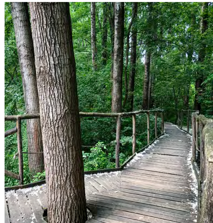
Fig. 329 / Small wooden interventions on the Little Danube: Wooden footbridge in Dunajský Klátov (Authors: L. Vitková & K. Smatanová).
